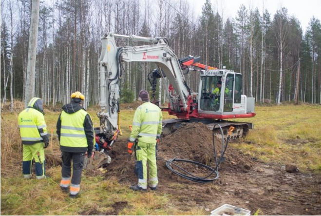
SKDG 201609:5. Kaivantoa 2 kaivetaan. Esa Haataja kuvassa toisena vasemmalta.
