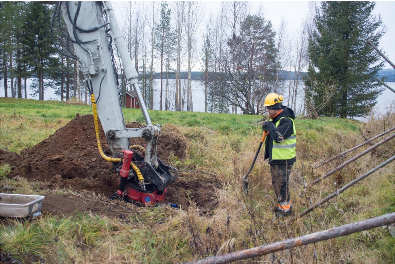
SKDG 201609:2. Esa Haataja valvomassa kaivannon 1 kaivutöitä.
