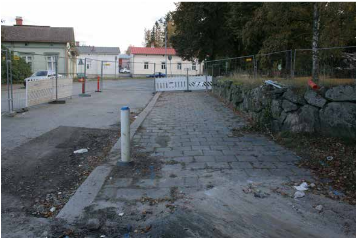
KUVA 2. Yleiskuva alueesta 2 ennen kaivuuta, vasemmalla vuoden 2009 koekuoppa (aukko asfaltissa). W-E, 12.10.2015, M. Helamaa. RMK 27916:4.
