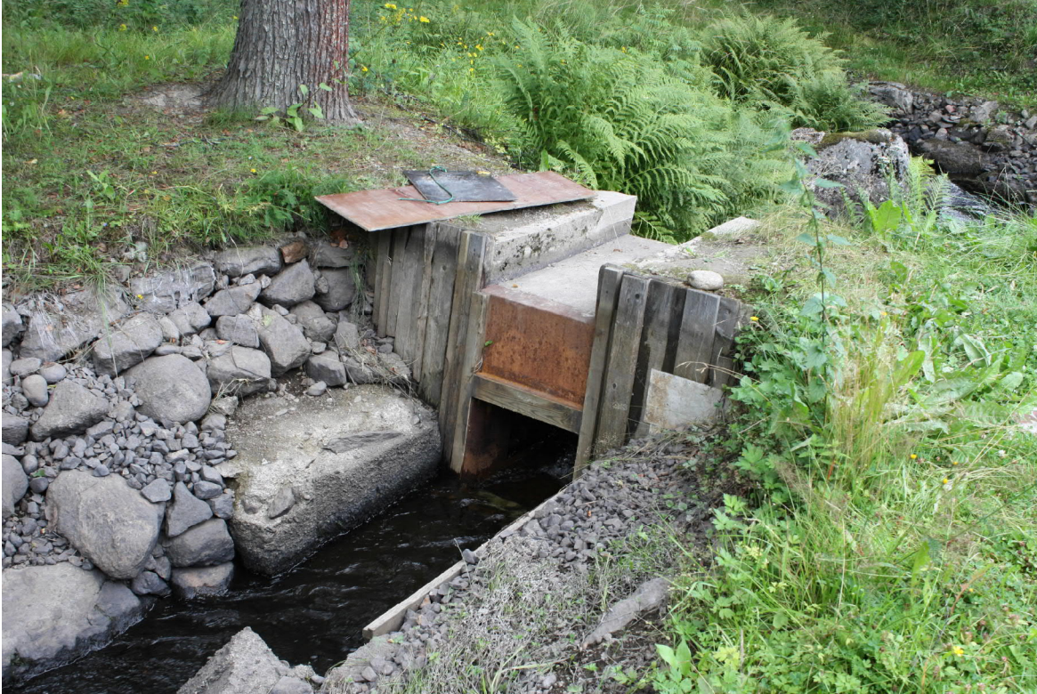
KYY 251 : 12 Ylempi (itäinen) betonipato luukkurakenteineen. Kaakosta. Vadim Adel 30.07.2009
