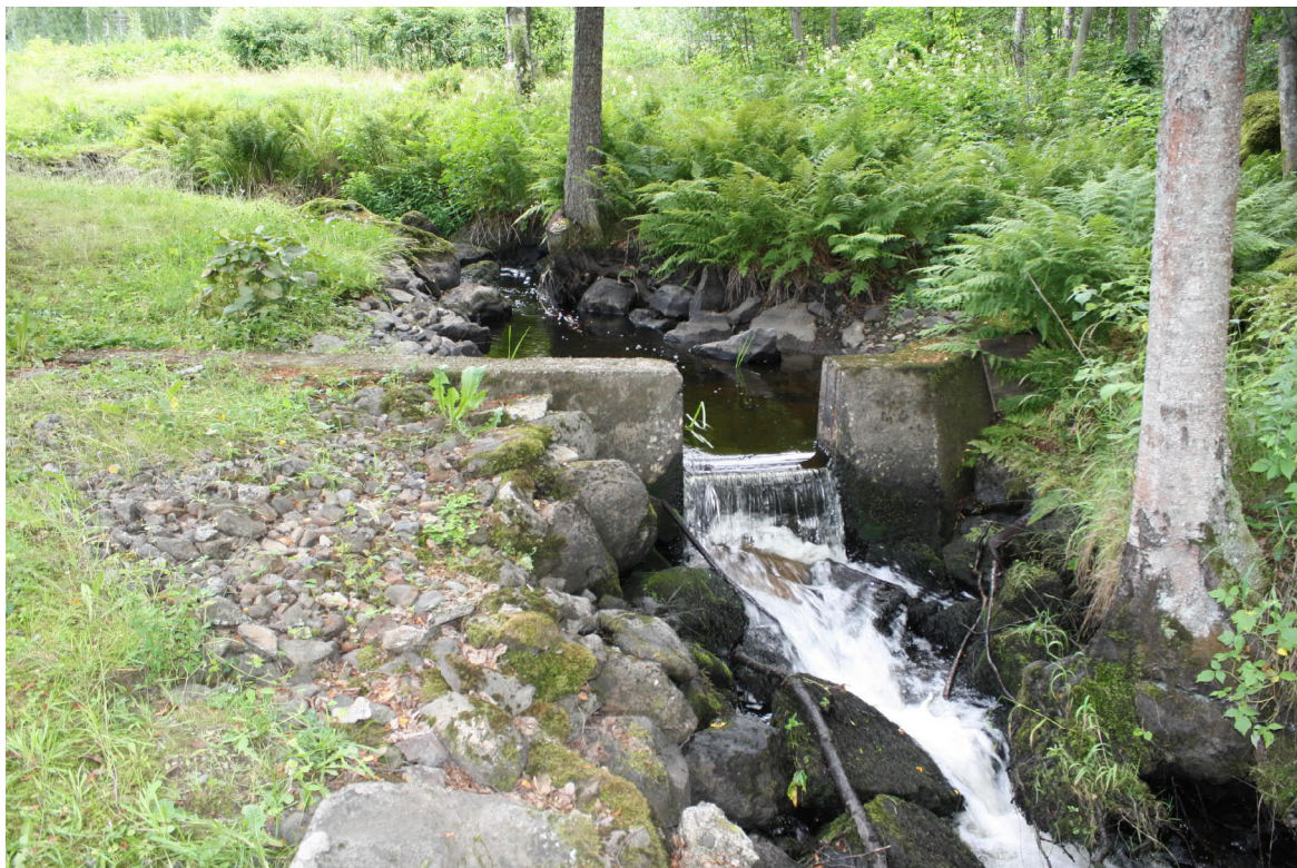
KYY 251 : 10 Lätinen betonipato. Suunnasta WNW Vadim Adel 30.07.2009
