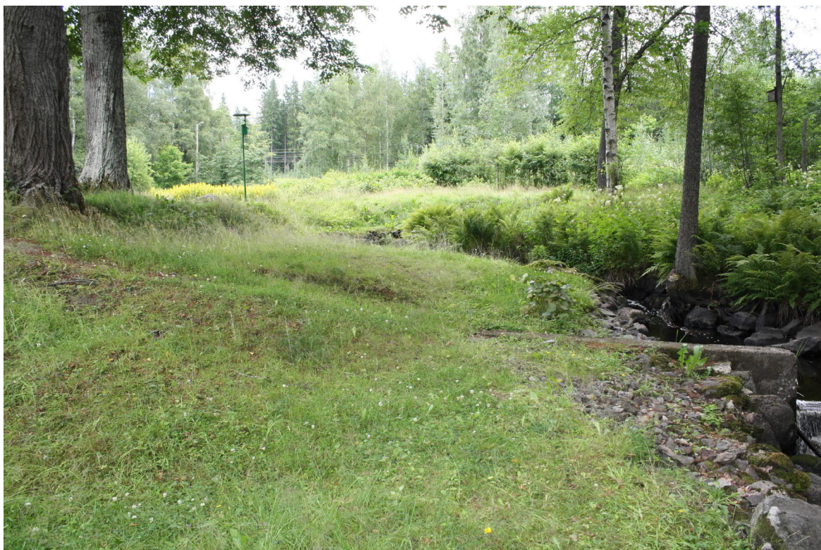
KYY 251 : 11 Tasanne betonisen padon NE-puolella ja ympäröivää maisemaa. Lännestä. Vadim Adel 30.07.2009
