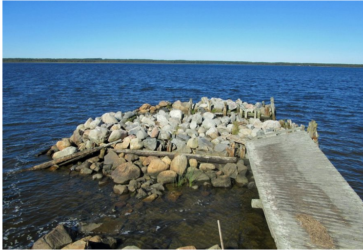
Laiturin kiviarkkujen jäänteet pohjoiseen.
