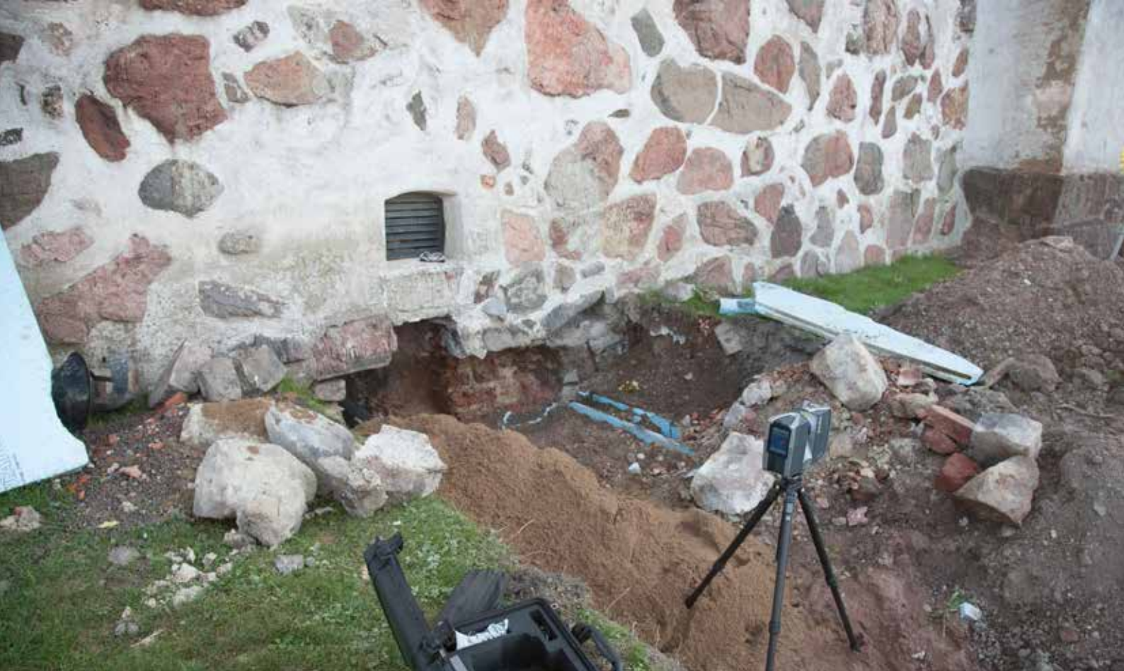
Kuva 3. Naantalin kirkon eteläseinän oviaukon pielet ja vanhemman tiilirakennuksen alue v. 2011. Kuva Muuritutkimus ky
