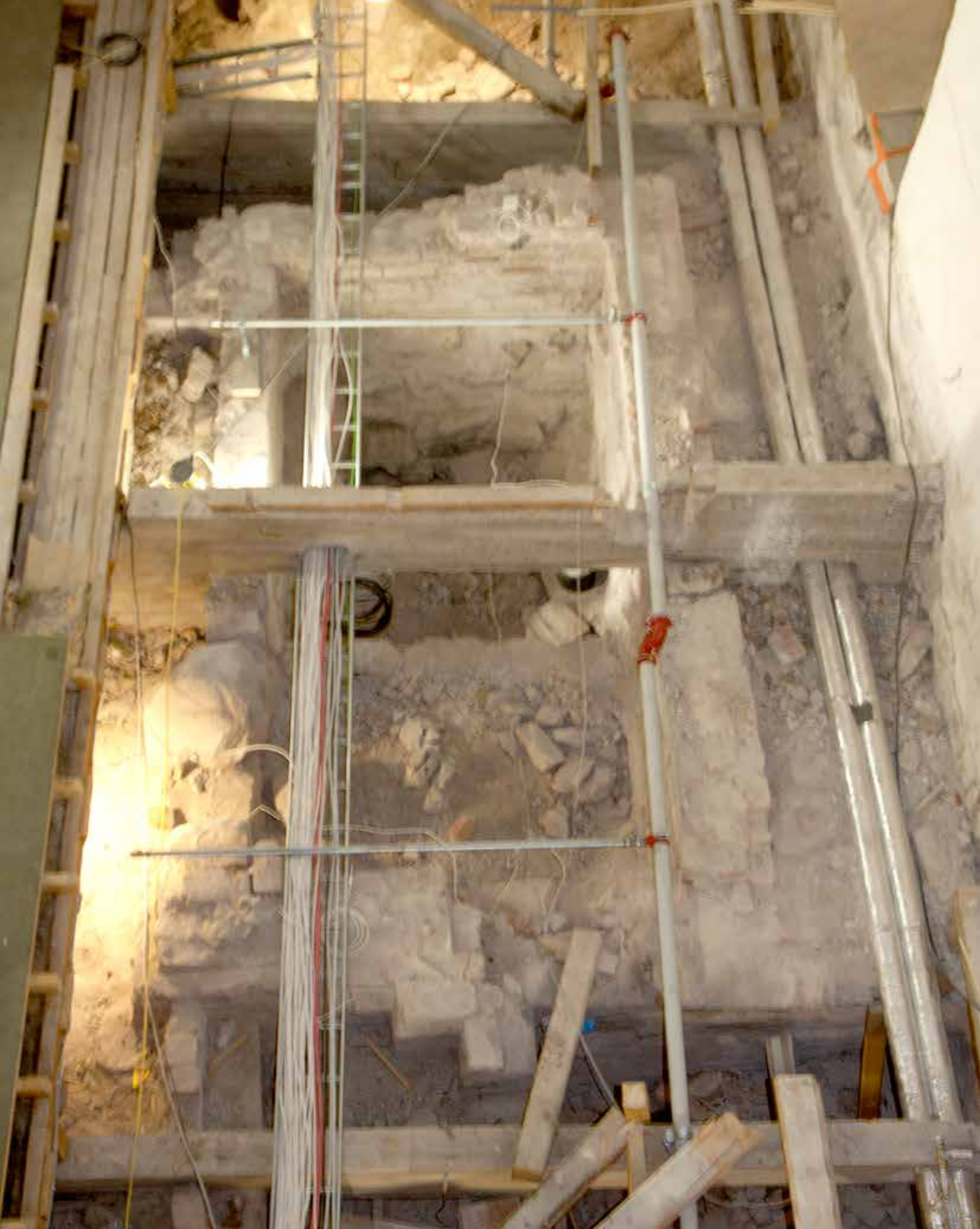
Kuva 2. Naantalin kirkon itäosan alttarirakenne v. 2011. Kuva Muuritutkimus ky
