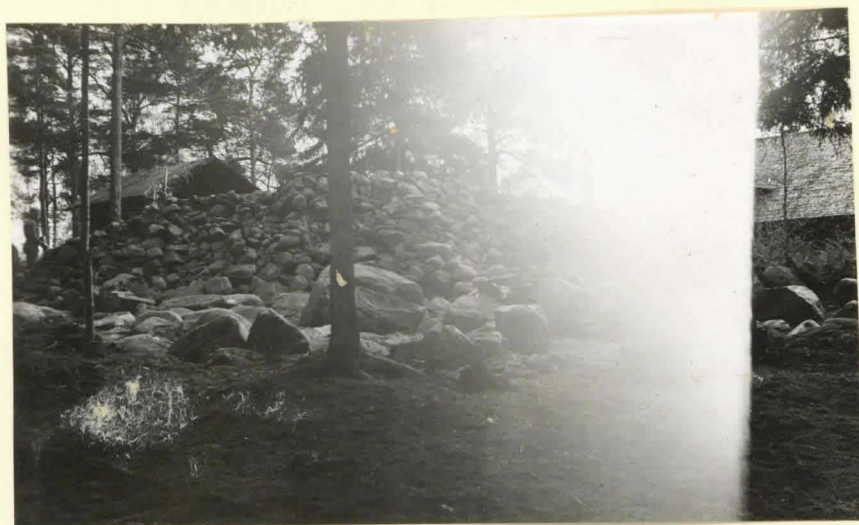
Vareen länsipuolisko purettuna. Kuva otettu lännestä. (kuv 15748)
