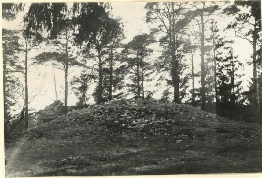
Vare I ennen purkamista, kuvattu koillisesta. (Luvy 15743)
