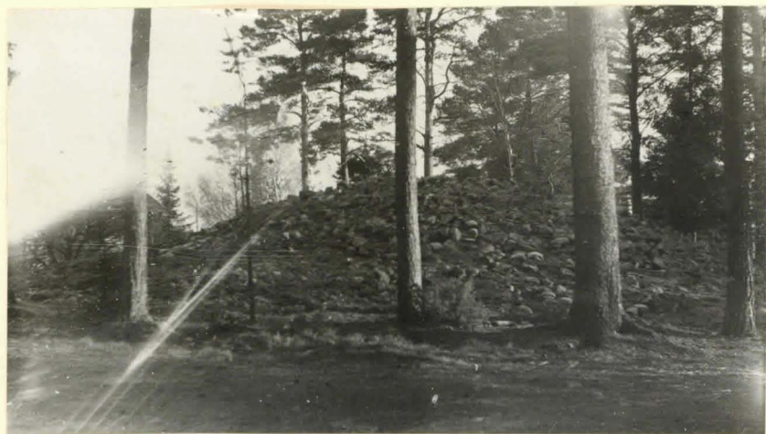
Vare I ennen purkamista, kuvattu loteesta. (Luvy 15745)
