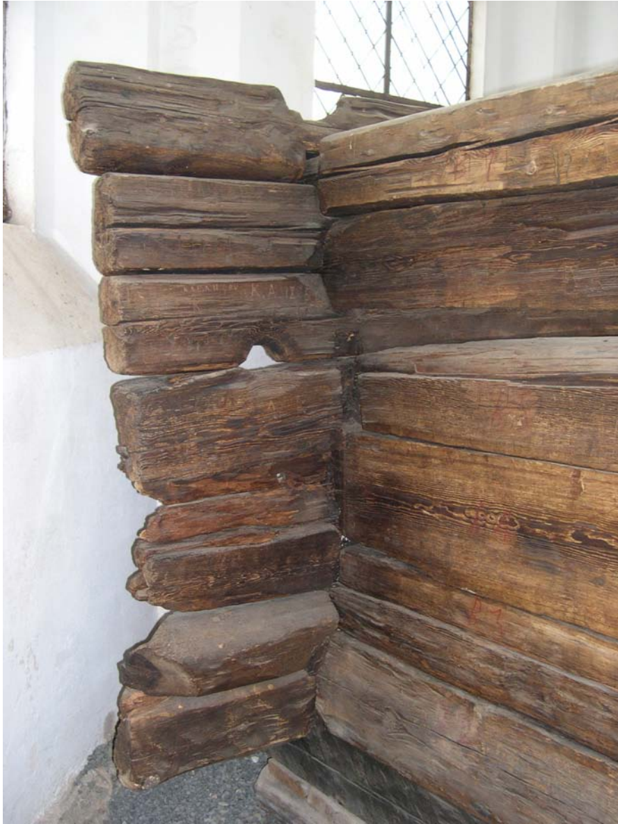
Aitan etuseinän yli tulevat sivuseinien päät ”posket”.
