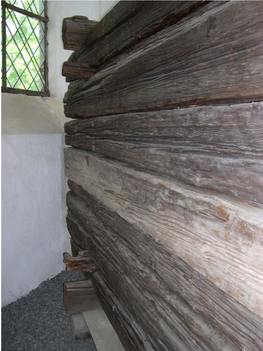
Saarnahuoneen luoteisseinä hirsikehikon takaa kuvattuna. Kuva: Niina Uusi-Seppä 2009.
