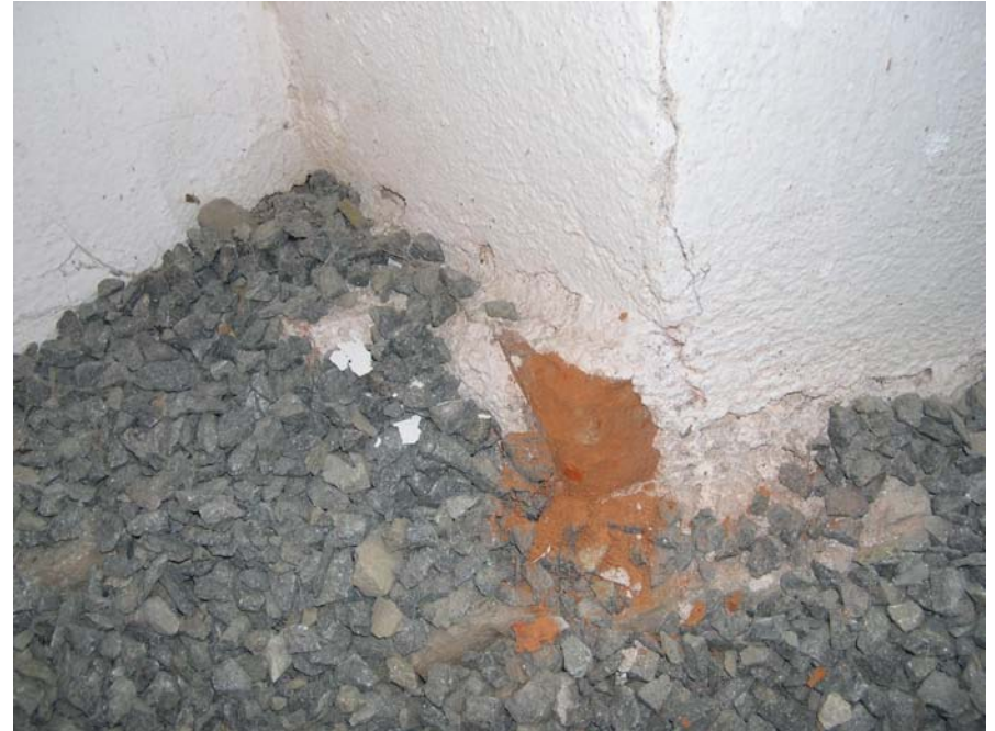
Kappelin soralattiaa ja tukipilarin alareunaa. Kuva Niina Uusi-Seppä 2009.
