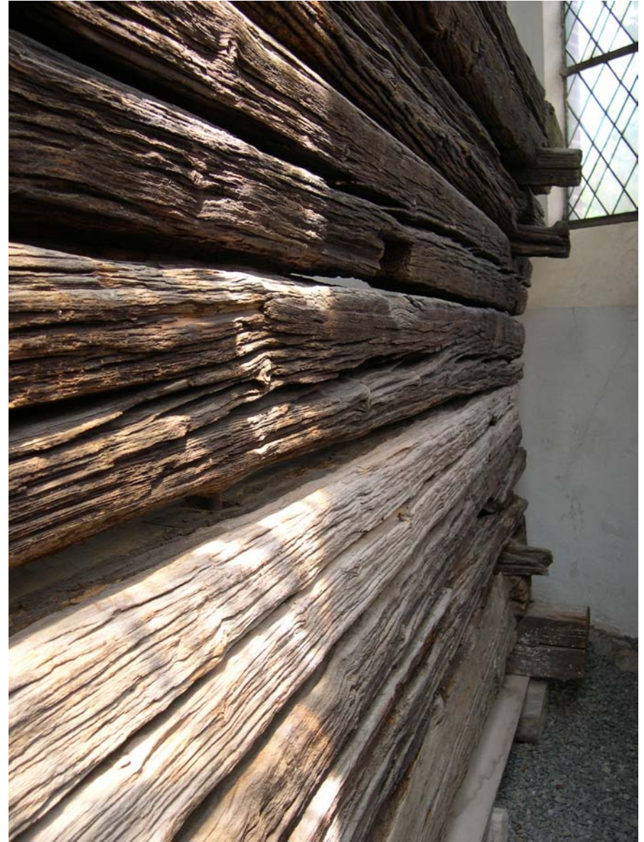
Saarnahuoneen kaakkoisseinä on kulunein ja ollut siis eniten alttiina valolle. Kuva: Niina Uusi-Seppä 2009.
