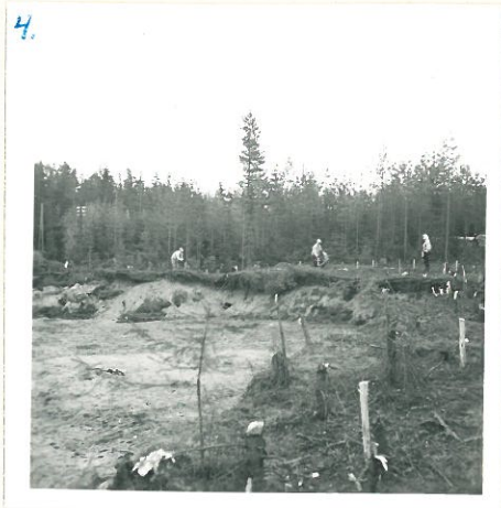
Kuva 7. Kaivausalueella paalutetaan 20.5.1959. Valokuvattu länsi puolelta Itäkaakkoos. (F. 23371)
