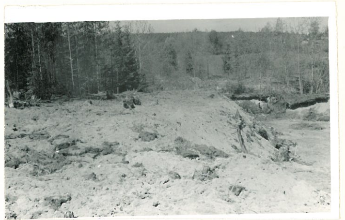
Kuva 36. Kaivausalueella peiteltyinä, vrt. kuva 20.
