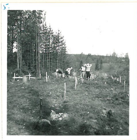
Kuva 9. Kaivaus alkaa 21.5.1959. Valokuvattu kaakosta luoteeseen. (F. 23373)
