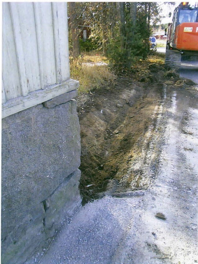
Kuva 21. H-alueen lounaisosaa avataan Anian rantatien laidalle. Vasemmassa laidassa Sapalan koillisen asuinrakennuksen nurkka. Kaivanto sijaitsee kohdalla, jossa on ollut Sapalan umpipihaan liittyvä rakennus vielä 1900-luvun alussa. Kuvaussuunta lounaaseen. Kuvaaja: Sami Raninen. KY 130: 44.
