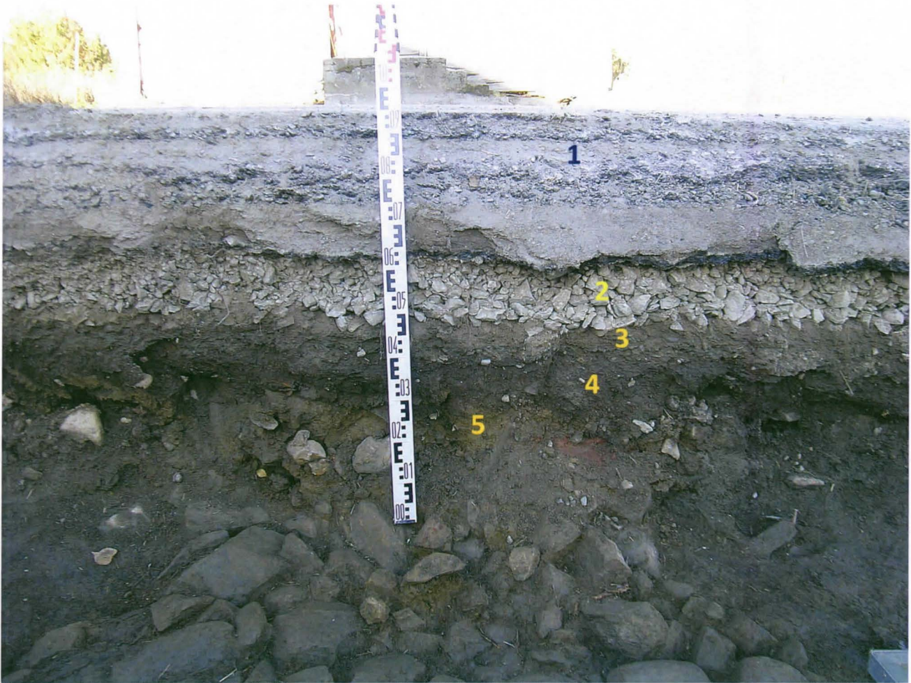
Kuva 19. G-v-alueen luoteisprofiilia rakenne G-KR1:n kohdalla. Anian rantatien toisella puolella Kaipilan aitta (kuvassa erottuvat parhaiten aitan betoniportaat). Kuvaan merkitty kerrokset: 1) asfalttikerrokset, 2) sepelikerros, 3) tummanharmaa hiekkakerros, 4) tummanharmaa savimultakerros, 5) kellertävännruskea hiekkakerros G-Y2. Kuvaaja: Sami Raninen. KYY 130: 19.
