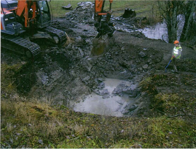
Kuva 34. Padotun Juoksianojan pohjaa ruopataan valvonnassa. Esille tulee harmaata savea. Tumma maa vasemmalla rantatörmällä on pengerluiskaan liittyvää resenttiä täyttöä. Kuvattu Juoksianojan sillalta kaakkoon päin. Kuvaaja: Sami Raninen. KY 130: 82.
