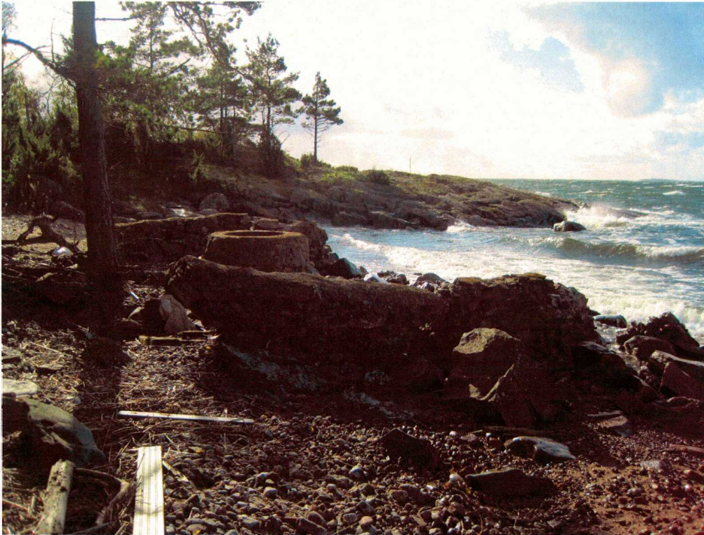
Kuva 11. Rysäkarin länsirannalla olevia betonista ja kivistä tehtyjä linnoitusrakenteita, joita aallokko on kuluttanut. Kuvattu koillisesta.
