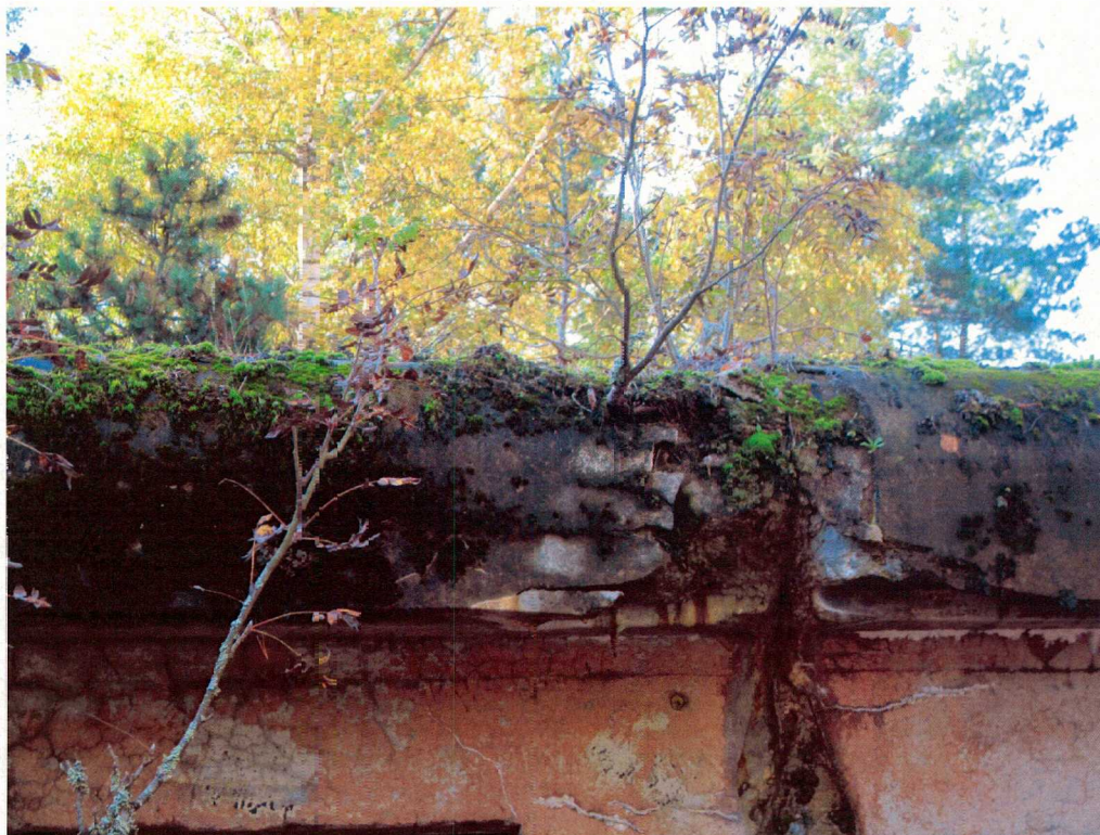
Kuva 9. Yksityiskohtakuva juuriston ja sadeveden hajottamasta tykkipatterin reunaosasta. Kuvattu pohjoisesta.
