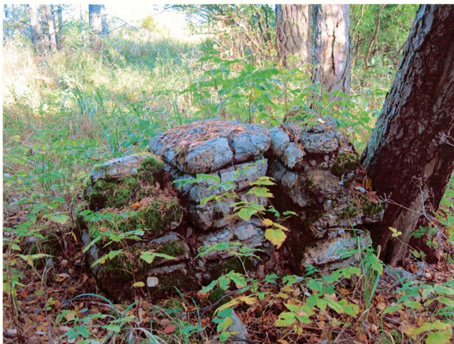
Kuva 2. Laastisäkkejä, joista päällyspaperi on maatonut pois.
