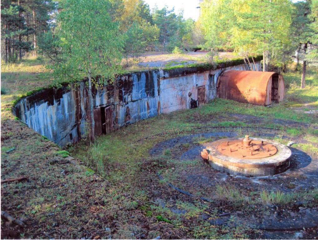
Kuva 7. Tykkipatterin tykkipihaa. Metallipelti muodostaa suojatun sisäänkäynnin maanalaisiin tiloihin vievälle oviaukolle. Kuvattu kaakosta.
