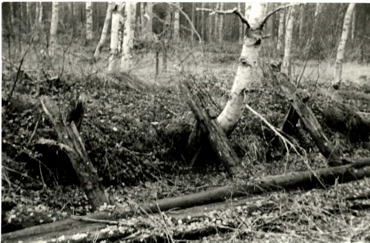
4. Kanavan alku-uoman laitarakenteita. (5329:32).
