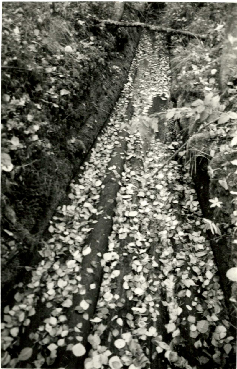
15. Kanavan tukevaa puupohjaa ja reunaa Talassaaren seutuvilla. Paikalla on ollut (Talassaaren) ränni. (5323:38).
