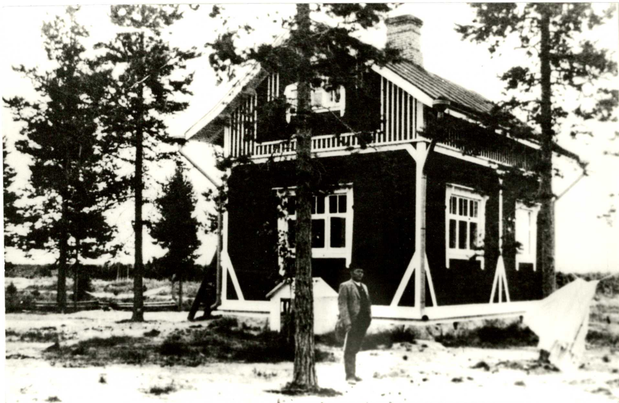
1. Kanavankaitsijan asunto. Pihalla loppuvalmisteluvaiheessa töitä ja uittoa valtion puolesta valvonut rakennusmestari K.H.Korhonen. (1988:4005).
