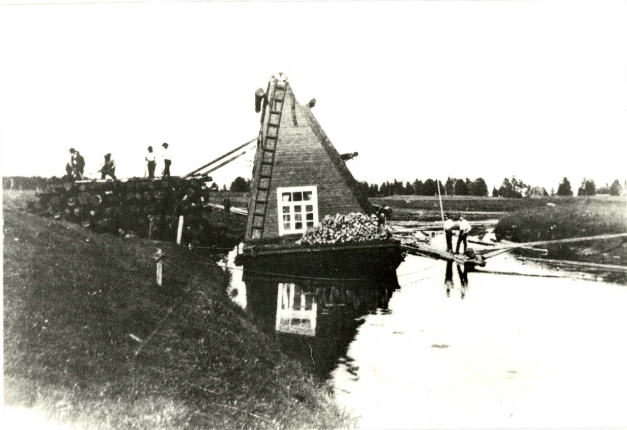
7. Nostokiramo kanavan alla. V. 1908 laittoi Raahen Puutavaraosakeyhtiö kanavan alle Neittävänjokeen 3 konevoimalla uivaa nostokiramo. (1988:4011).
