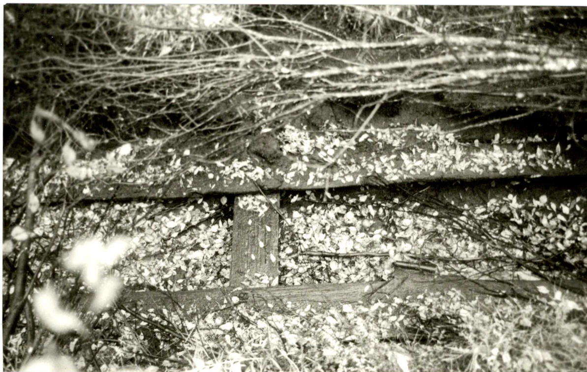
21. Kanavan pohjassa olevaa pohjarakennetta. (5326:6).
