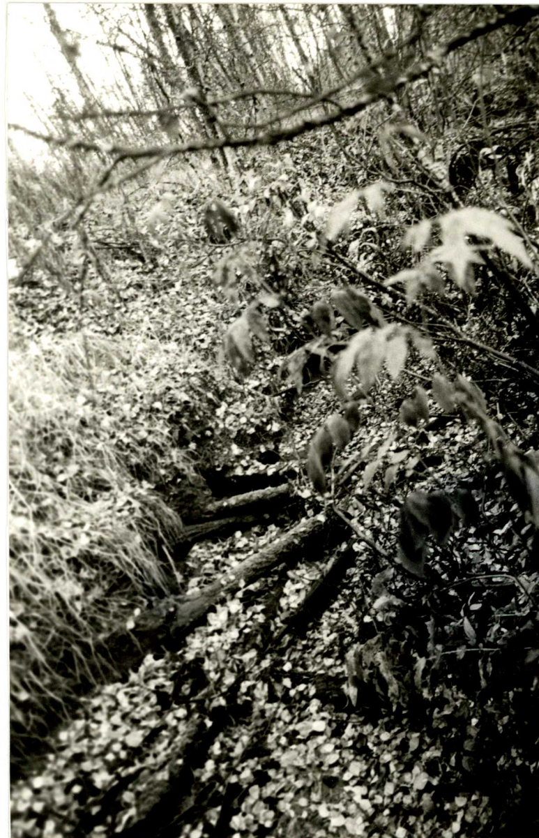
34. Kanavaa ja uittolaitejäänteitä. (5327:28).
