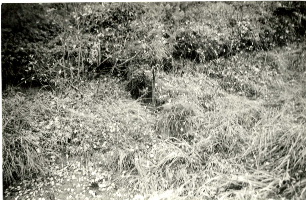
20. Kanavaa ja pohjarakenteita. Kuva otettu (Lievosen) rännin kohdalta ennen ns. Aaron mökkiä. (5325:27).
