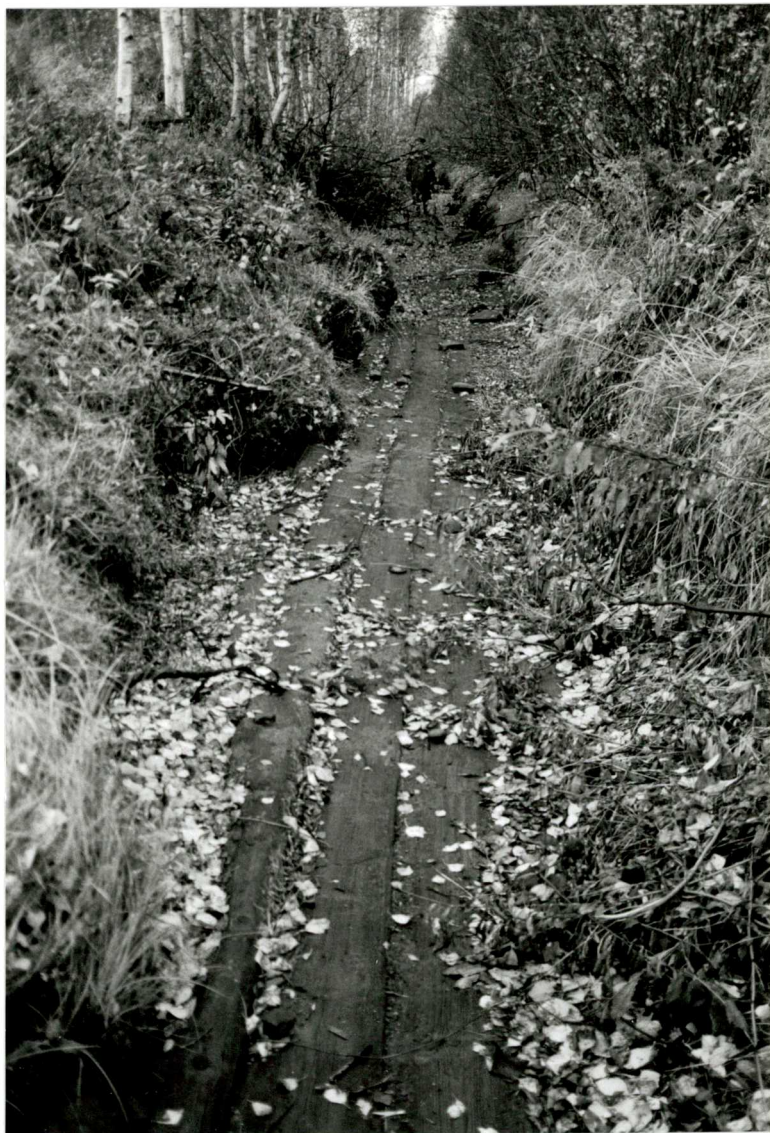
25. Kanavan tukevaa puu- pohjaa. (5326:25).
