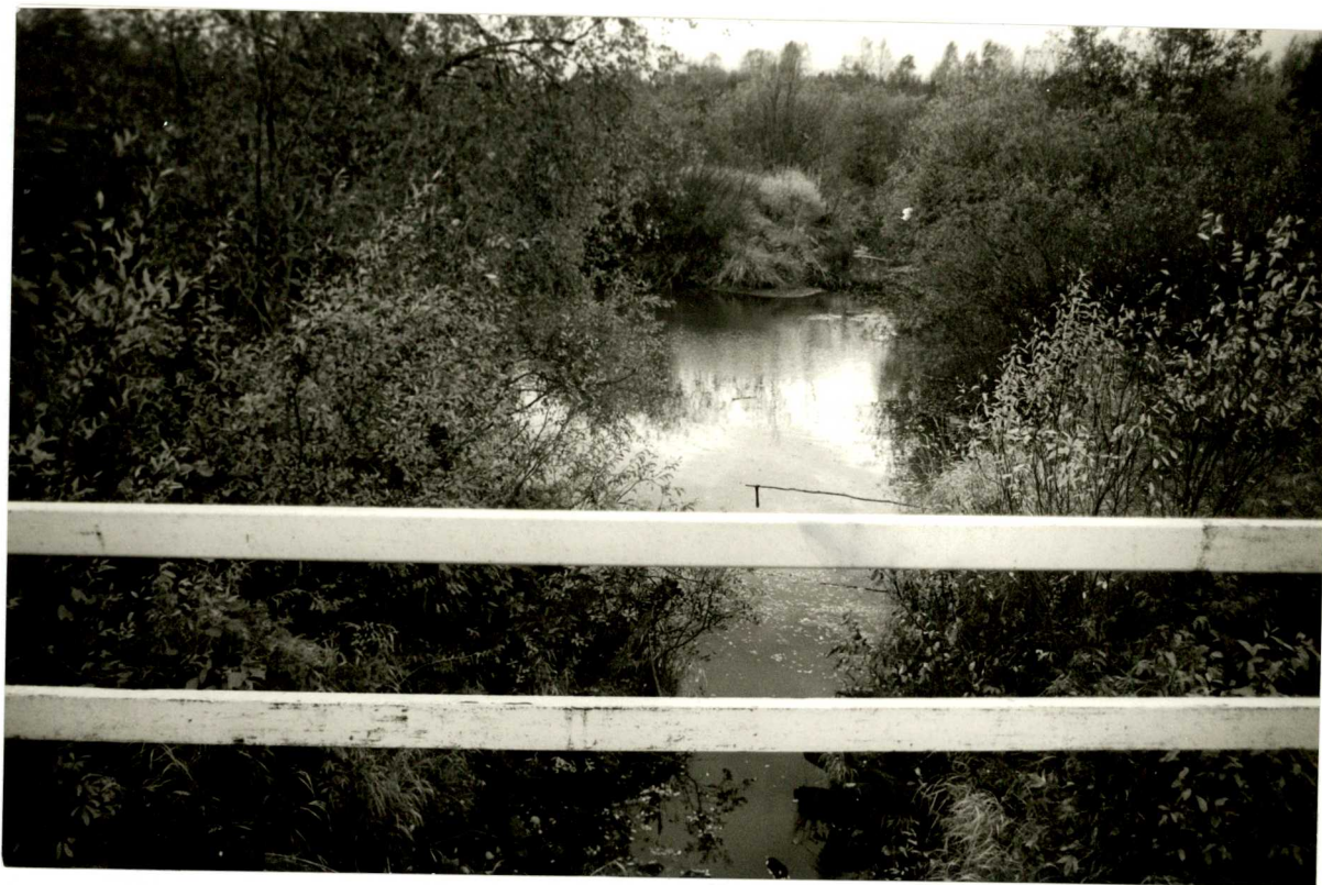
42. Kuva sillalta länteen, Neittävänjoelle. (5328:22).
