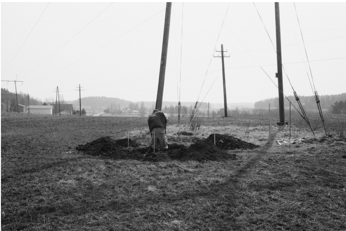
f. 140741 Luumyllynkoski, yleiskuva. Keskellä rakennettavan voimajohtopylvään 4 paikka. Pohjoisesta.
