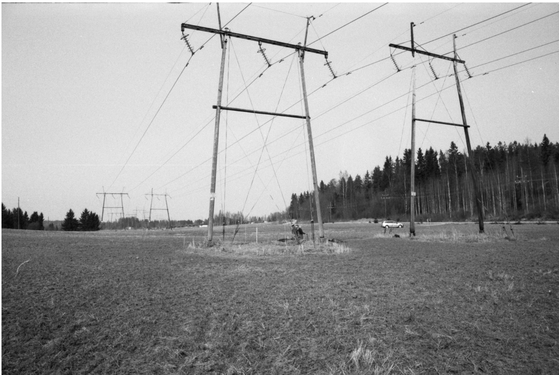
f. 140740 Luumyllynkoski, yleiskuva. Keskellä rakennettavan voimajohtopylvään 4 paikka. Etelästä.
