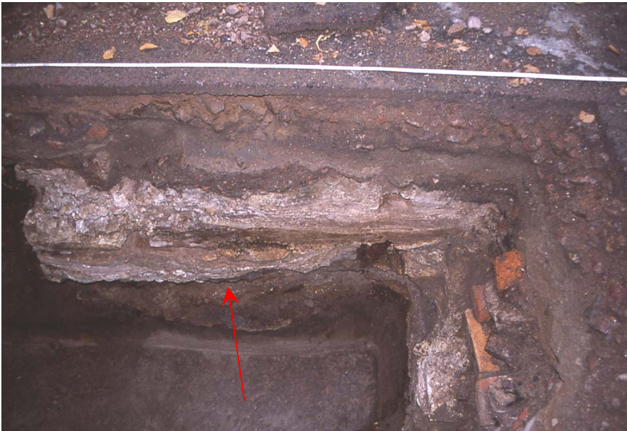
Kuva 3. Koeojan lounaispäädyssä oleva betonirakenne.
