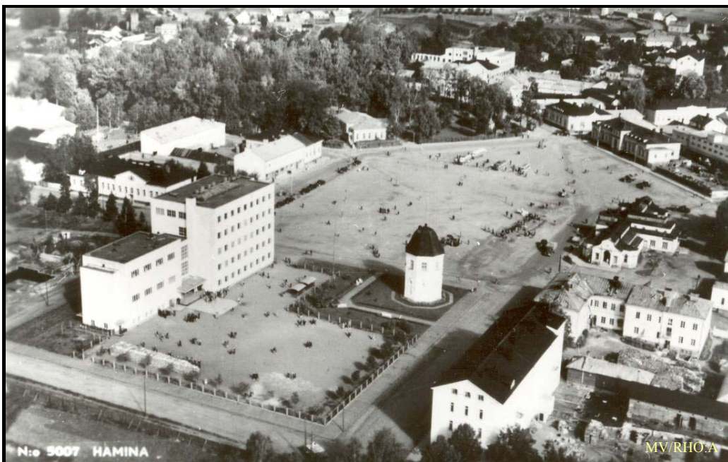
Kuva 4. Toisen maailmansodan jälkeen otettu ilmakuva. (MV/RHOn kuva-arkisto. Kokoelma: Tampereen yliopisto, kansatieteen laitos, Ala-Könnin kokoelmat: Hamina 106.)
