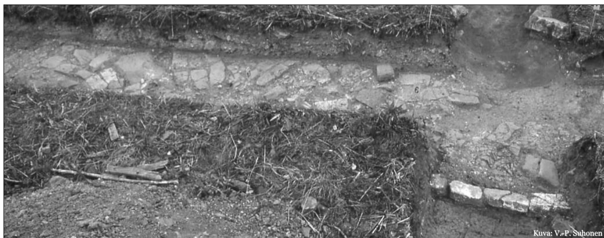
Kuva 13: Lähikuva tiilirakenteesta R206.
