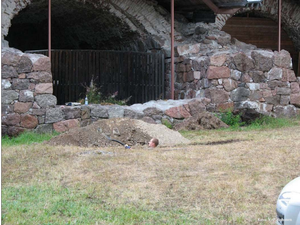
Kuva 1: Bastionin pihan koeojaa 2 kaivetaan.
