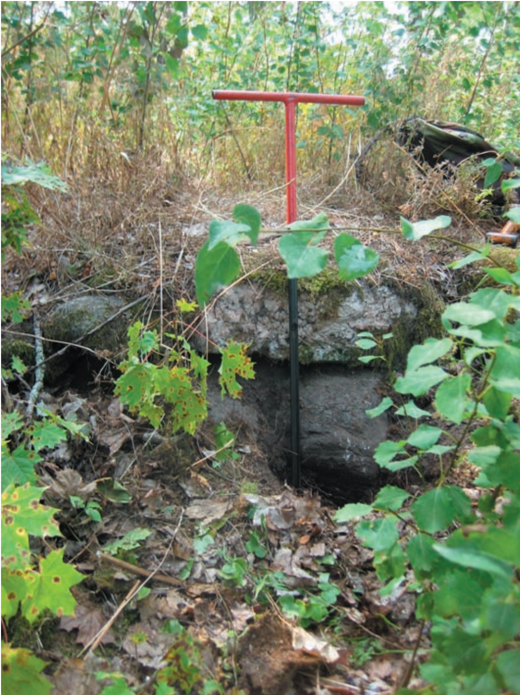
Kuva 4. Rakenteen 2 seinämä kohdassa, johon kaivettiin koepisto 4. Koepistosta löytyi tiilen ja laastin kappaleita. Kaira mittana.
