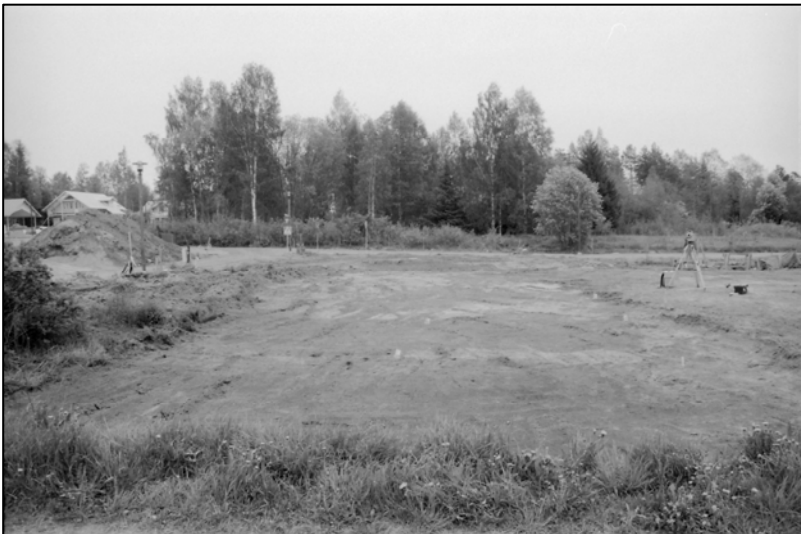
Neg. nro 142487. Yleiskuva alueesta 5050-60/991-1005 pintamaan poiston jälkeen. Lännestä. Kuvannut Katja Vuoristo.
