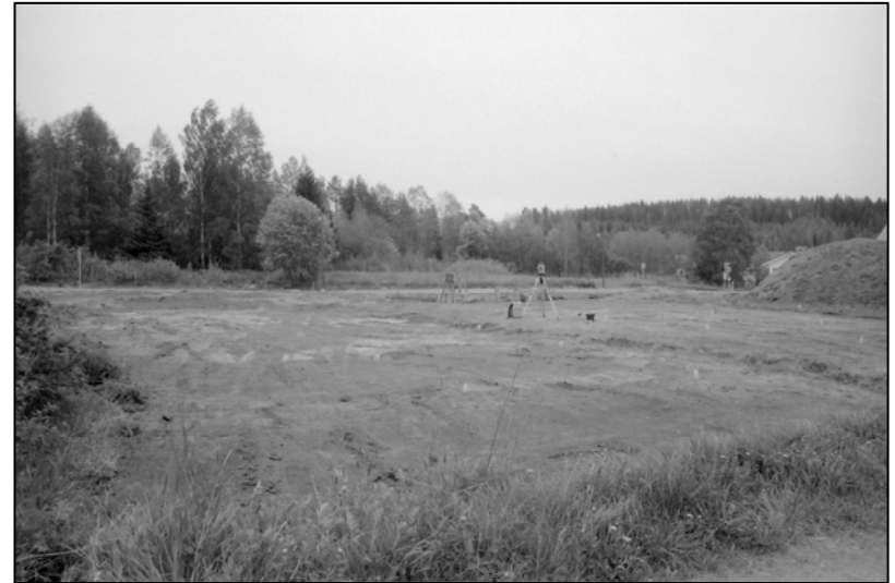
Neg. nro 142486. Yleiskuva alueesta 5037-67/991-1005 pintamaan poiston jälkeen. Luoteesta. Kuvannut Katja Vuoristo.
