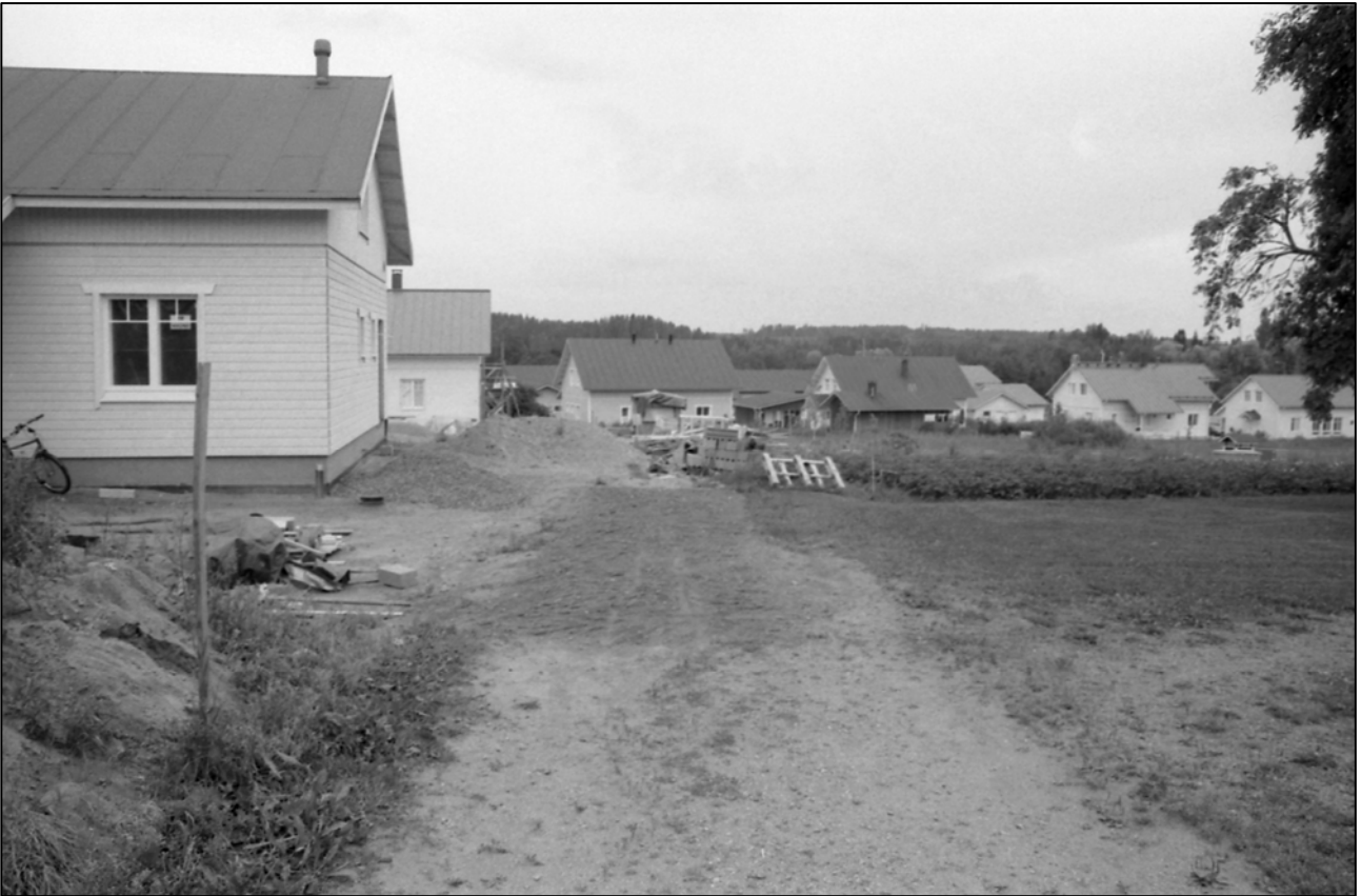
Neg. nro 142651. Alue 5020-30/989-991 täytettynä. Pohjoisesta. Kuvannut Esa Mikkola.
