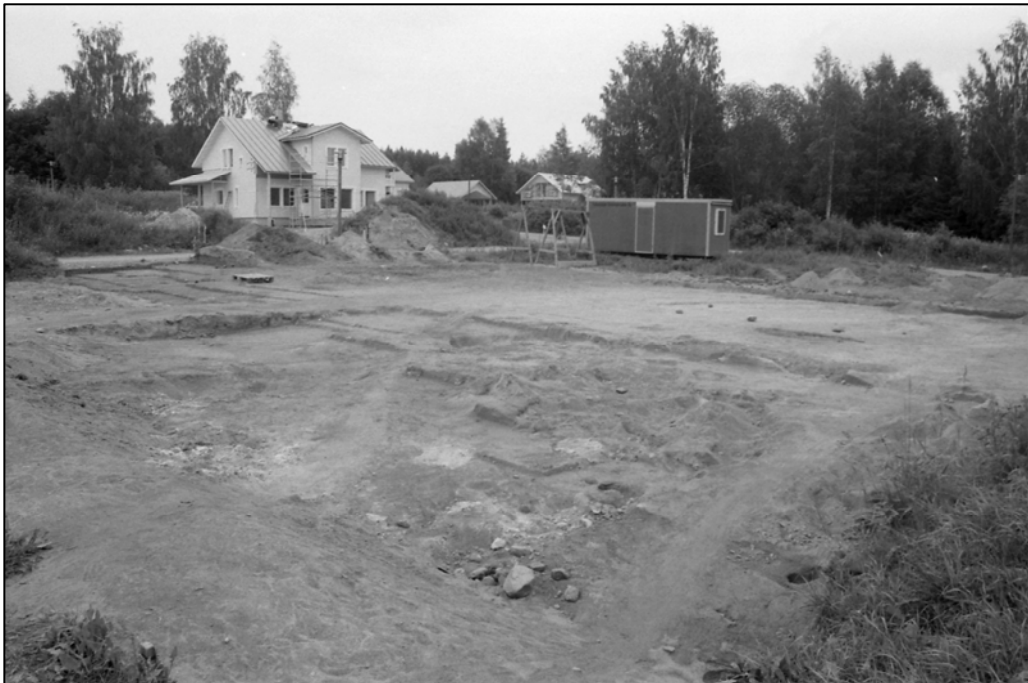
Neg. nro 142652. Alueet 5037-60/991-1005 ja 5060-67/997-1004 kaivausten päätyttyä. Lounaasta. Kuvannut Esa Mikkola.
