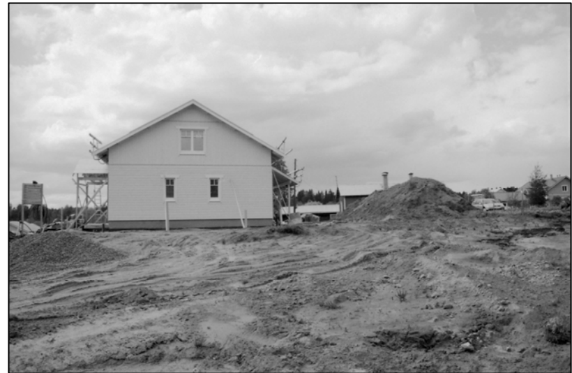
Neg. nro 142484. Yleiskuva vapautetusta tonttialueesta. Idästä. Kuvannut Katja Vuoristo.
