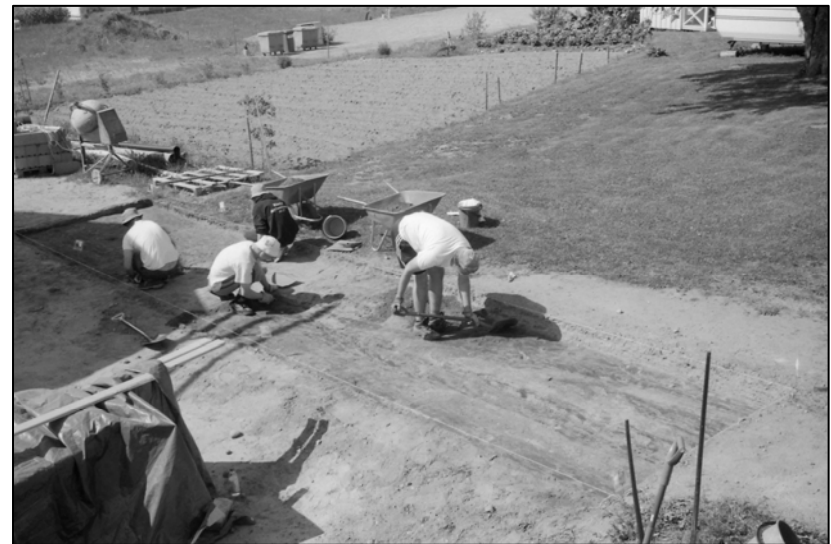
Neg. nro 142498. Työkuva. Vanhaa tietä poistetaan alueella 5020-30/989-991. Koillisesta. Kuvannut Katja Vuoristo.
