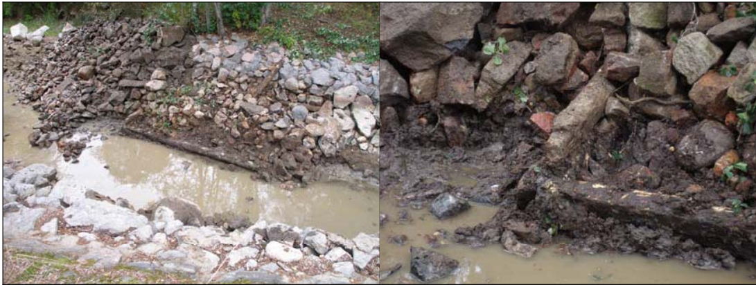
Kuvat 31 ja 32. Vasen kuva. Yleiskuva luoteisrannan vanhasta siltarakenteesta. Kanavan keskellä ollut hirsi on tässä vaiheessa jo poistettu. Kuvaussuunta SE-NW. WP/Museovirasto. Oikea kuva. Yksityiskohtakuva sillan luoteisrannan hirsiarkun kulmasta. Kuvaussuunta SE-NW. WP/Museovirasto.
