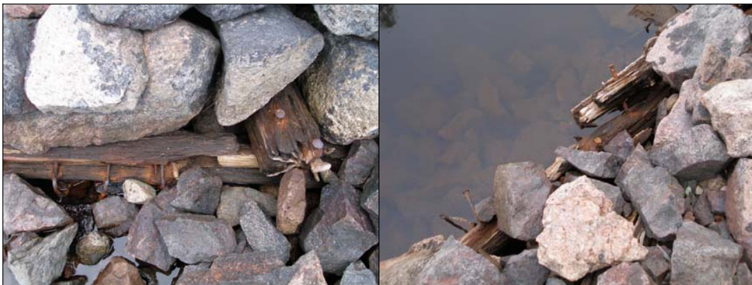
Kuvat 27 ja 28. Kanavan B-laidan koillispäässä olevia nauvoja ja koukkuja. TK/Museovirasto.
