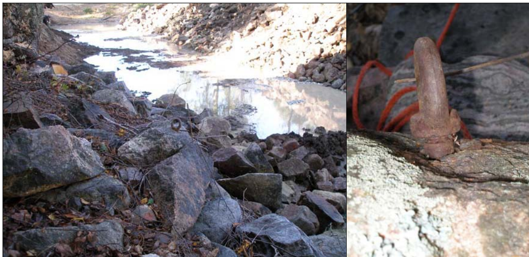
Kuvat 10 ja 11. Vasen kuva. C-laidan kiveyksessä olleita kiinnityslenkkejä. Kuvaussuunta: E-W. WP/Museovirasto. Oikea kuva Kierteiden perusteella lenkit ovat moderneja. WP/Museovirasto.
