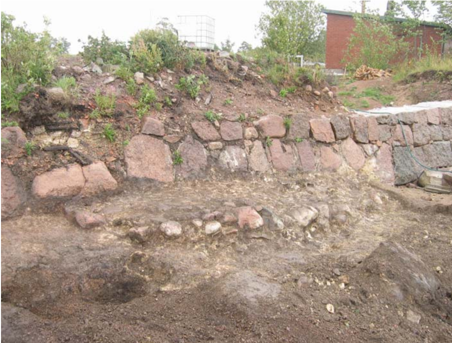
Kuva 3. Vallin 4B:n edessä oleva muurattu kivinen tukirakenne, suuntaan SE, (R.V. 2007)
