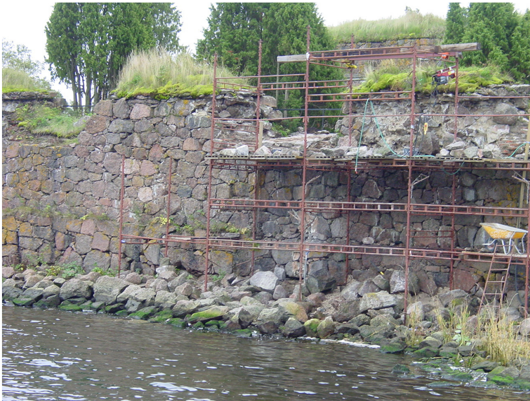
Dokumentoitu ampuma-aukko kuvan keskellä rakennusteline vierellään.
