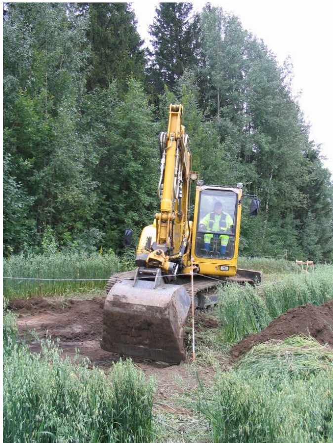
Kuva 3. Kaivausalue 1. Peltokerrosta poistetaan kaivinkoneella. Kuv. Satu Koivisto (digikuva 12).
