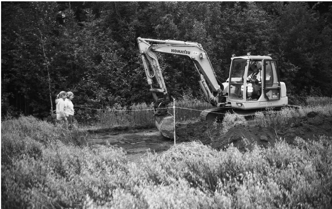
Kaivausalue 1. Peltokerrosta poistetaan kaivinkoneella. f. 144284 Tiina Kinnunen ja Anna-Maria Salonen valvomassa.
