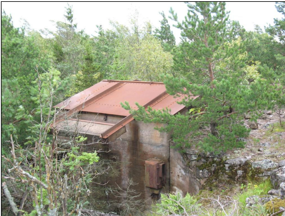
Kuva 24 Valonheittimen suoja-aseman yläosa Rankissa (kohde 85). Kuva: John Lagerstedt 2007.
