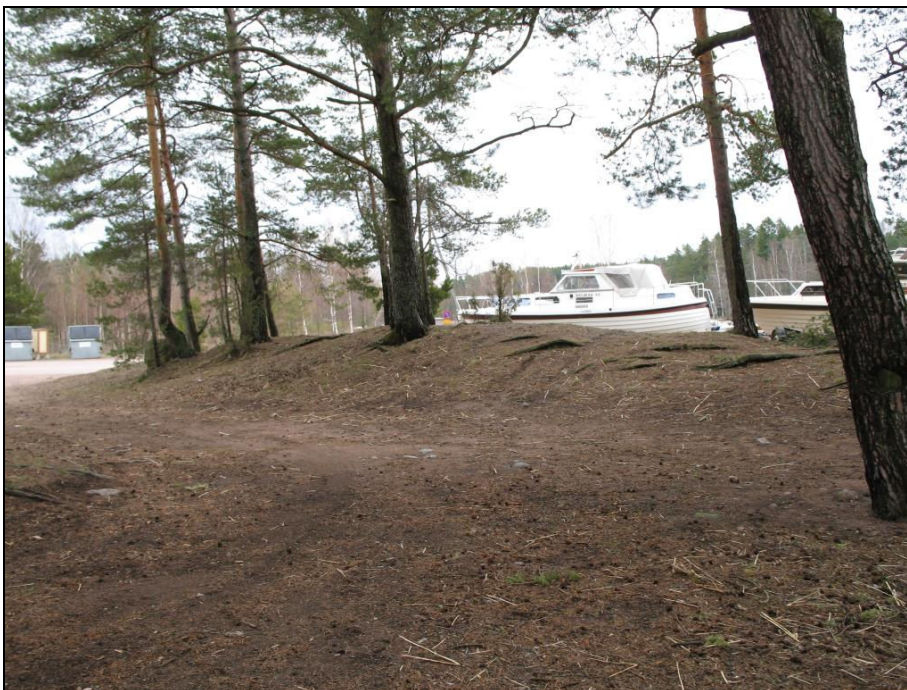
Kuva 9 Pyhtään Lökörenin tykkipatterin hiekkaperäisestä maasta rakennetut rintasuojat ovat erodoituneet. Kuva: John Lagerstedt 2007.
