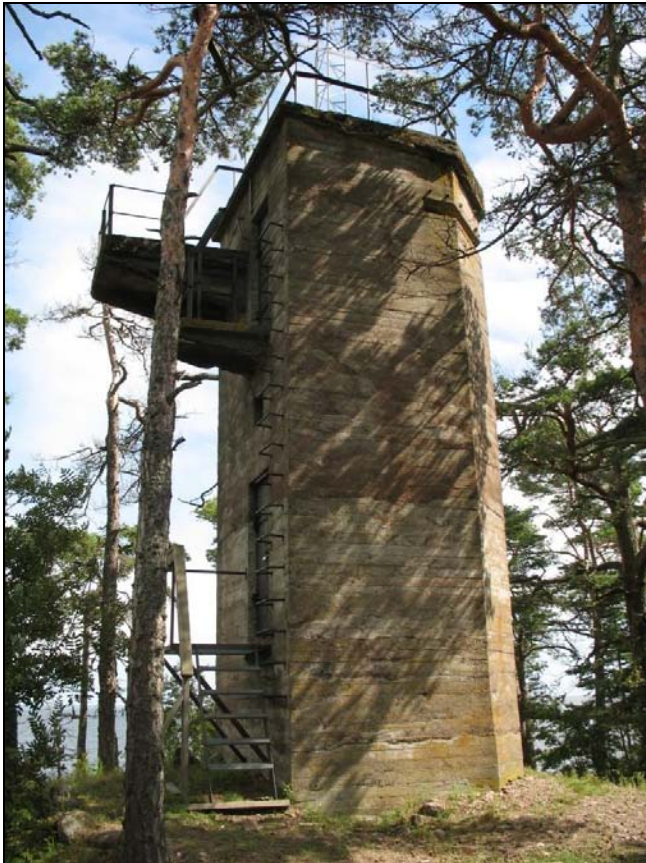
Kuva 8 Pyhtään Kaunissaarella sijaitseva 1930-luvun alussa rakennettu Rikaman-mallinen tulenjohto ja mittaustorni (kohde 15). Tornimalli on saanut nimensä sen kehittäjän eversti Johan Lambert Rikaman mukaan. Kuva: John Lagerstedt 2007.
