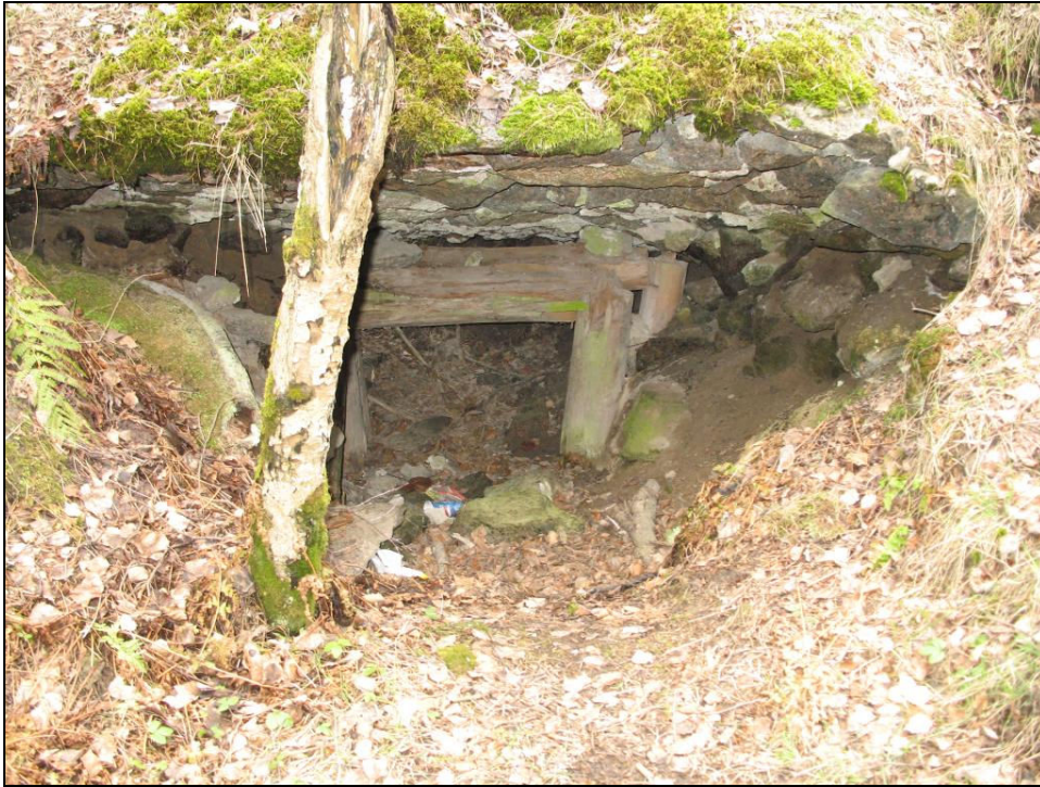
Kuva 12 Hirsillä ja sementillä vahvistetun tuliseman oviaukko Kotkan Langinkoskella (kohde 49). Aseman katto on luhistunut. Kuva: John Lagerstedt 2007.
