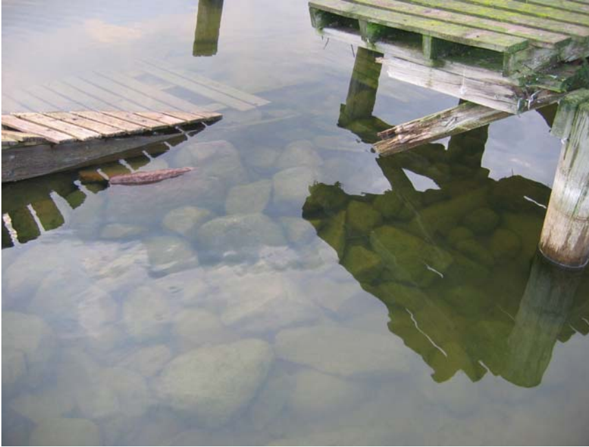
Kuva 4. Kiviperustaa Vohloisten vanhan puulaiturin alla. Kuva kaakosta.
