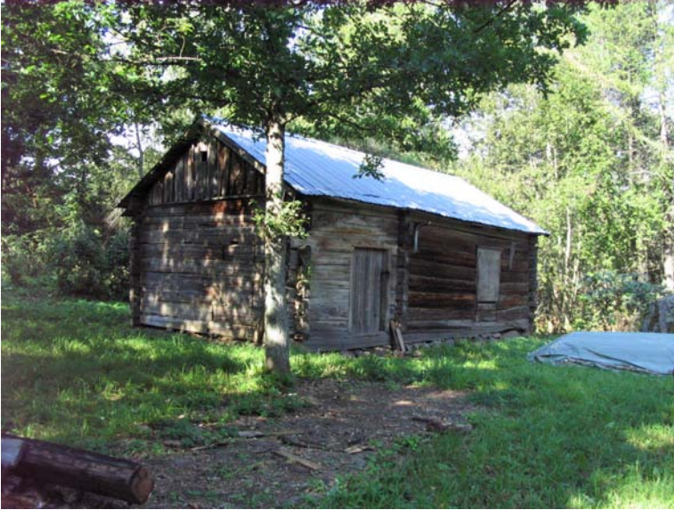
Kuva 10. Hinkapyölin vanha päärakennus. Etelästä. Kuv. K. Vuoristo.
