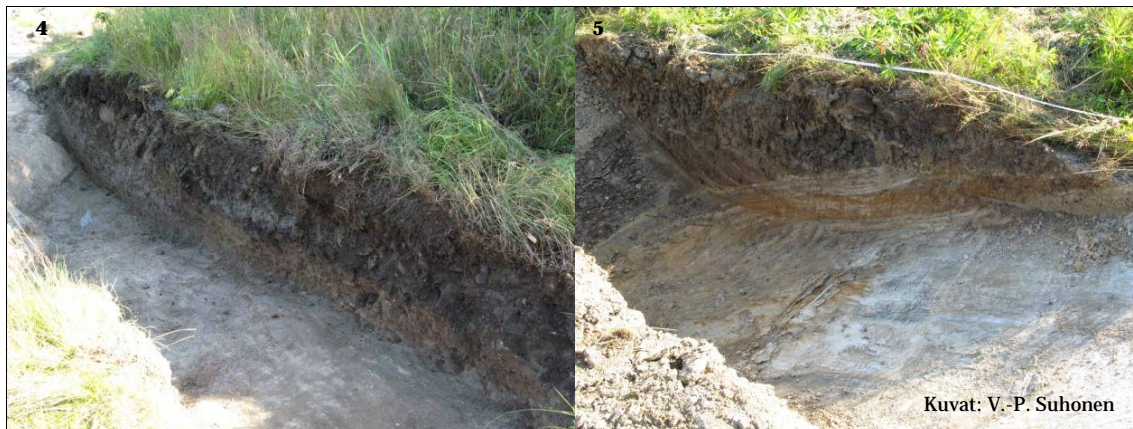
Kuvat 4-5: 4) Kaakkois-luoteissuuntaisen koeojan kaakkoispään itäprofiili; 5) Kaakkois-luoteissuuntaisen koeojan luoteispään itäprofiili.
