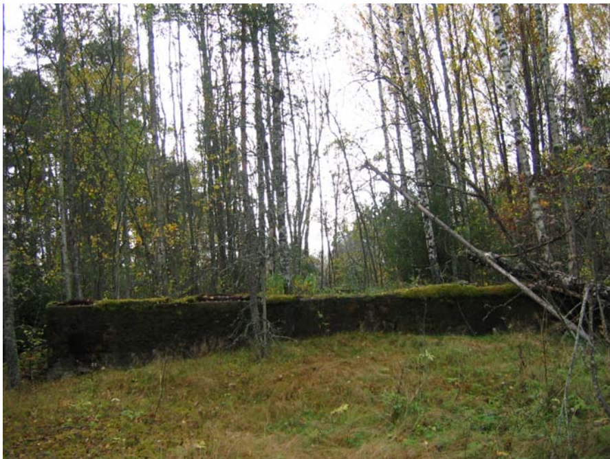
Kuva 12. Kirkkonummi Ängsholm. Ängsholmin tilan länsipuolella sijaitseva betoniperustus, kuvattu pohjoisesta.
