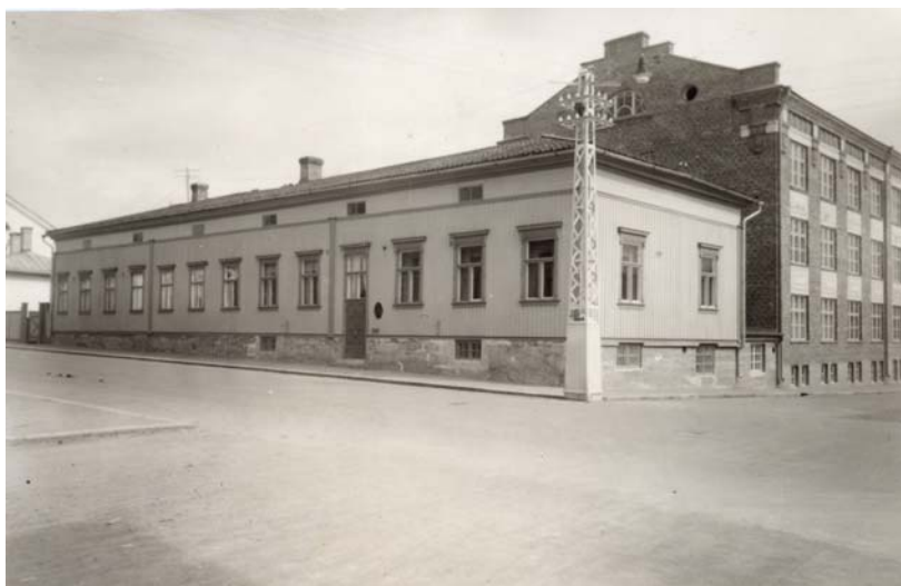
Kuva 14. Puurakennus Isonkadun varrella, pitsitehdas sen takana. 2/2/7. ”Ns. Lassfolks träbyggnad”. Kuvattu 1935 ja kuvaaja Ingolf Friman. Lähde: Pietarsaaren kaupunginmuseon kuva-arkisto.
