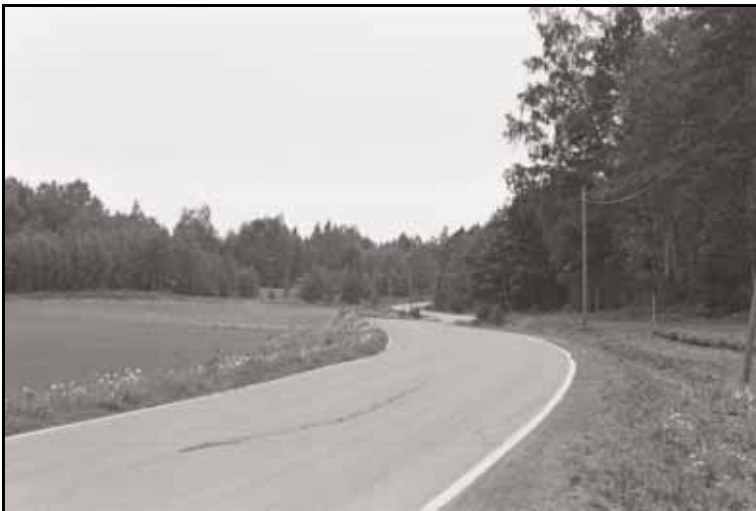
Kuva 13: Hiidentien kulkua Hattulan Hietainportinmäessä, kohde 9. Maakaasuputkilinjan ja tien leikkauskohta metsän reunassa.
