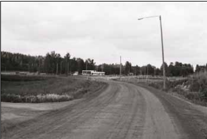
125712:50 Hattula Sattulan Teboil. Sattulasta Takajärven suuntaan menevän tielinjan ja maakaasuputkilinjan leikkauskohta. Taustalla entinen Sattulan Teboil, jonka takaa Hiidentie kulkee. Lännessä 30.5.2007 (JT).
