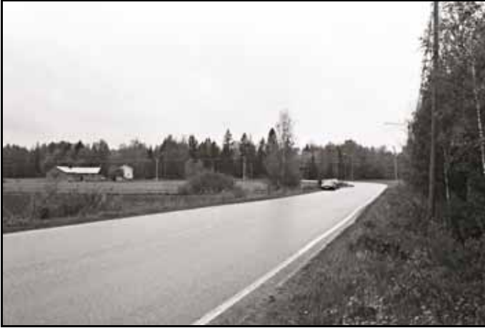
125712:31 Hämeenlinna Tauru-Peltola. Härkätien ja maakaasuputkilinjan leikkauskohta auton kohdalla. Koillisesta 25.5.2007 (JT).
