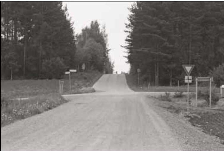
125712:48 Hattula Hietainportinmäki 2. Pelkolaan kohti Lehijärven rantaa menevän tien ja Hiidentien risteys. Maakaasuputkilinja kulkee suunnilleen metsänreunan tasalla. Lounaasta 30.5.2007 (JT).
