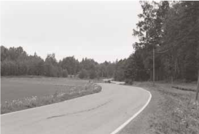
125712:49 Hattula Hietainportinmäki 1. Mutkittelevaa Hiidentietä Sattulan suunnasta katsottuna. Maakaasuputkilinja leikkaa Hiidentien Hietainportinmäessä metsänreunassa. Kaakosta 30.5.2007 (JT).
