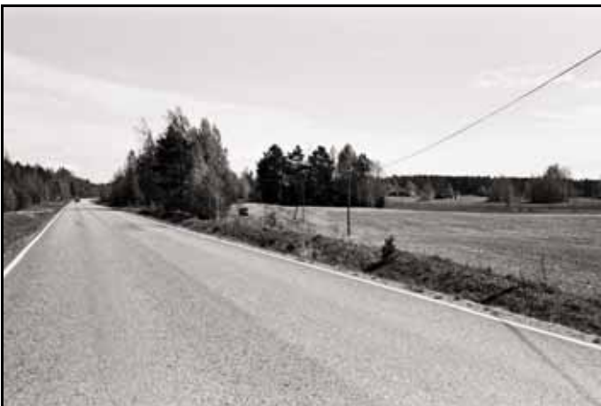
125712:18 Lempäälä Harhala. Maakaasuputken ja vanhan kuninkaan-kartastossa näkyvän tieuran leikkauskohta Lempäälän Harhalassa lähellä Mäyhjärveä. Käytöstä jäänyt vanha tie on uuden asfalttitien alapuolella. Pohjoisesta 15.5.2007 (JT).
