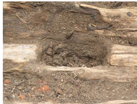
Kuvat 16 ja 17. Vasemmanpuoleisessa kuvassa R1b:n salvoskohta (vasen seinusta, hirren alkupää) ja oikeanpuoleisessa kuvassa salvoksesta lähikuva. Digikuvat nrot 13 ja 22 Kuvaaja: Tiia Ikonen
