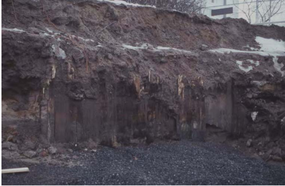
Kuva 22. Rakenteen R12 pystylaudoitus kuvattuna luoteeseen. Dia 125697:85, MV/RHOA. Kuvaaja: Marika Hyttinen.
