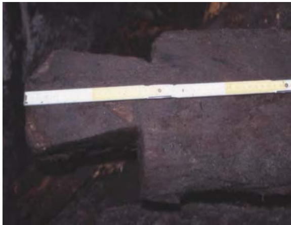
Kuva 28. Lohenpyrstösalvosinen hirsi R3:sta. Dia 125697:24, MV/RHOA. Kuvaaja: Marika Hyttinen
