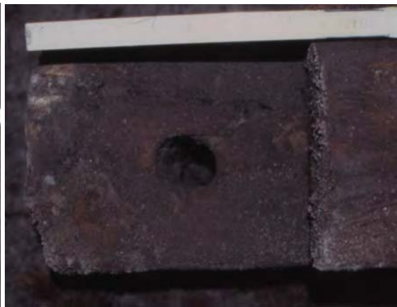
Kuva 29. Saman hirren toinen pää eli lohenpyrstösalvos tapinreiällä. Dia 125697:22, MV/RHOA. Kuvaaja: Marika Hyttinen.
