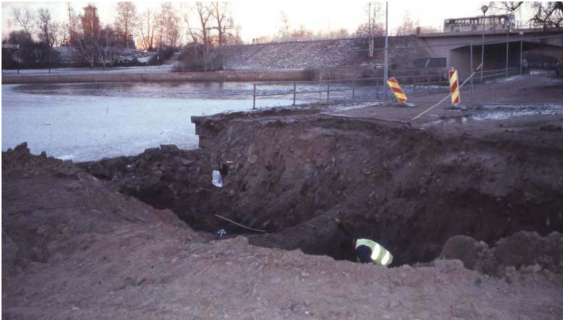
Kuva 14. Työnmaa-aikaisen avo-ojan alkupää. Koillisprofiilissa mittanauhan kohdalla sijaitsi rakenne R1. Rakenteen eteläpuolella kulki kuvassakin näkyvä jätevesiputki. Dia 125697:10, NMV:RHOA. Kuvaja: Marika Hyttinen.
