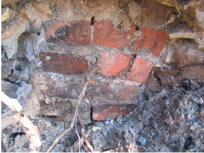
Kuva 11. Rakenteen R1 muurattua tiiliseinämää kuvattuna itään. Digikuva nro 1. Kuvaaja: Tiia Ikonen, MV/RHO.
