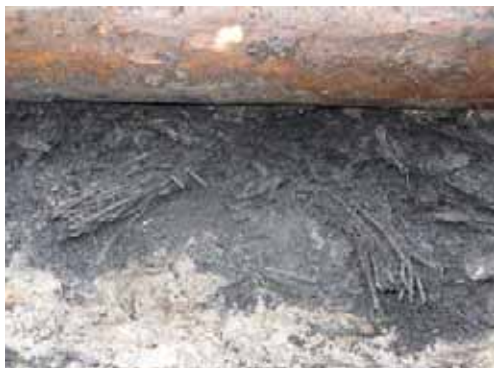
Kuva 35. Digitaalinen kuva nro 42. Risukimppuja sullottuna hirsien väliin. Kuvaaja: M Hyttinen, MV/RHO.
