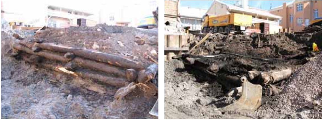
Kuva 17 (vas.). R11a, hirsirakenteen länsipääty. Digitaalikuva MV/RHO.
