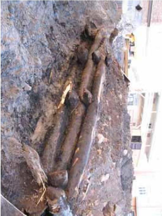
Kuva 260. R11a, luoteissivu. Hirsirakennuksen perusta.
