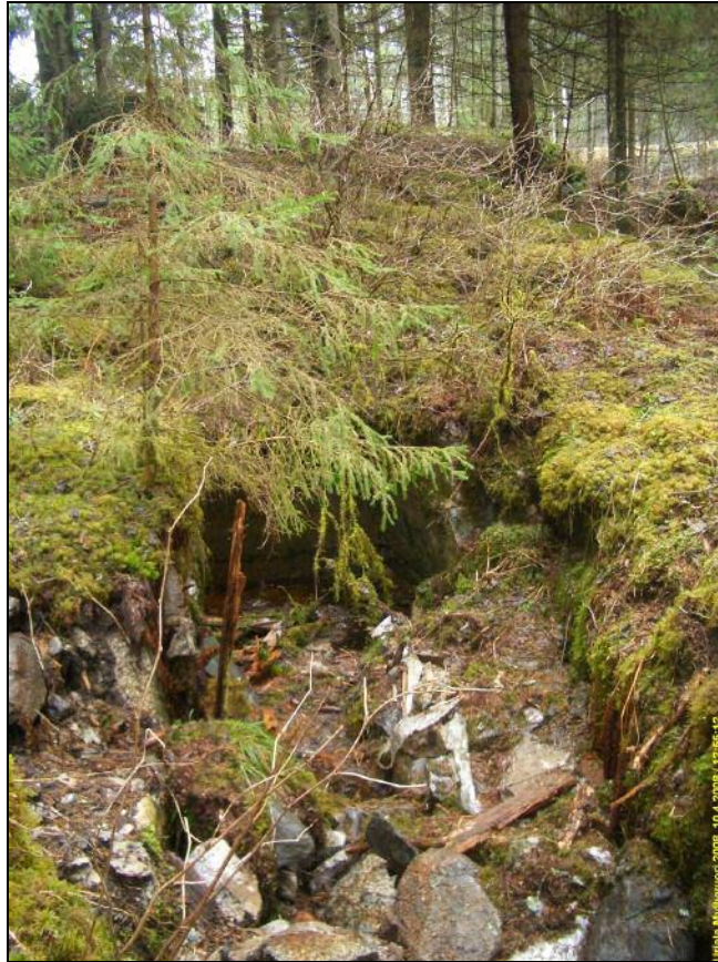
Vanhaa myllynuoman päätä, jossa betonirakennetta. Myllynraunio taustalla. Kuvattu koilliseen.
