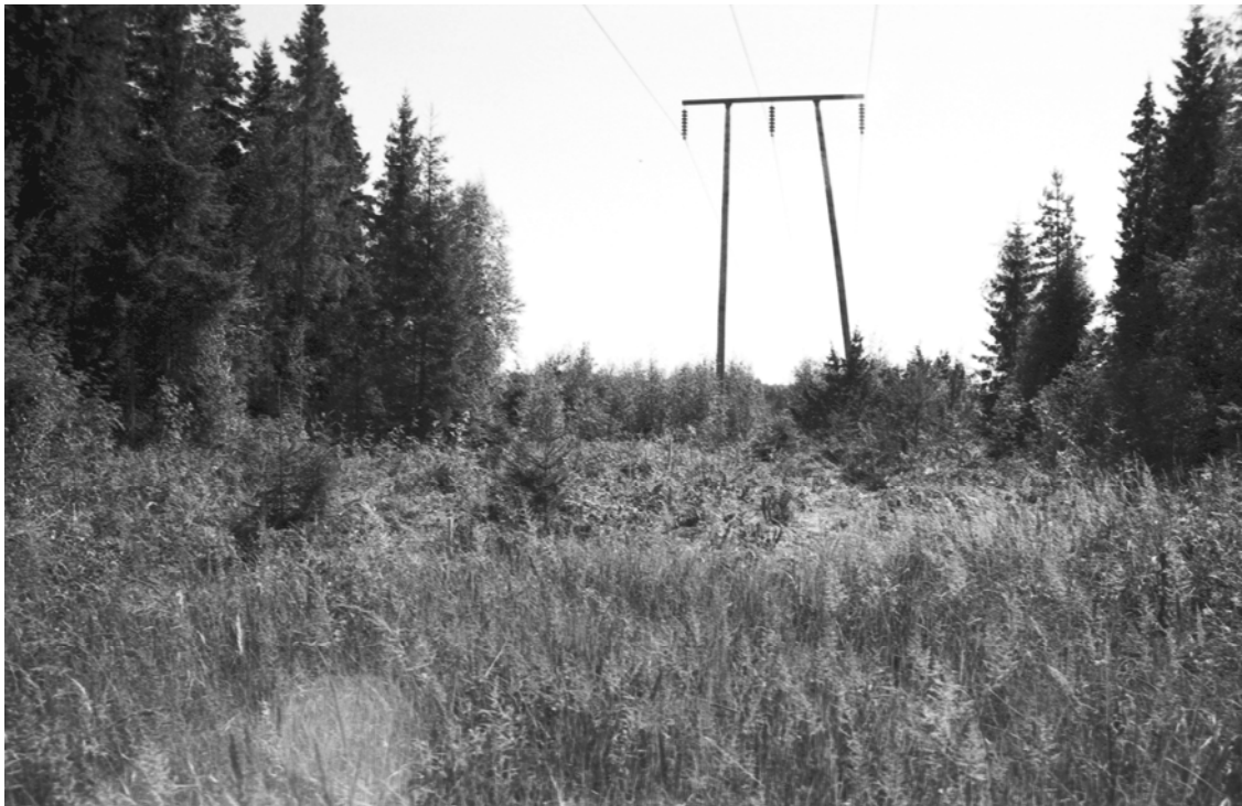
Kuva 1. Tolpan 215 paikka paalutettuna. Kuvattu luoteesta. (f. 143225)
