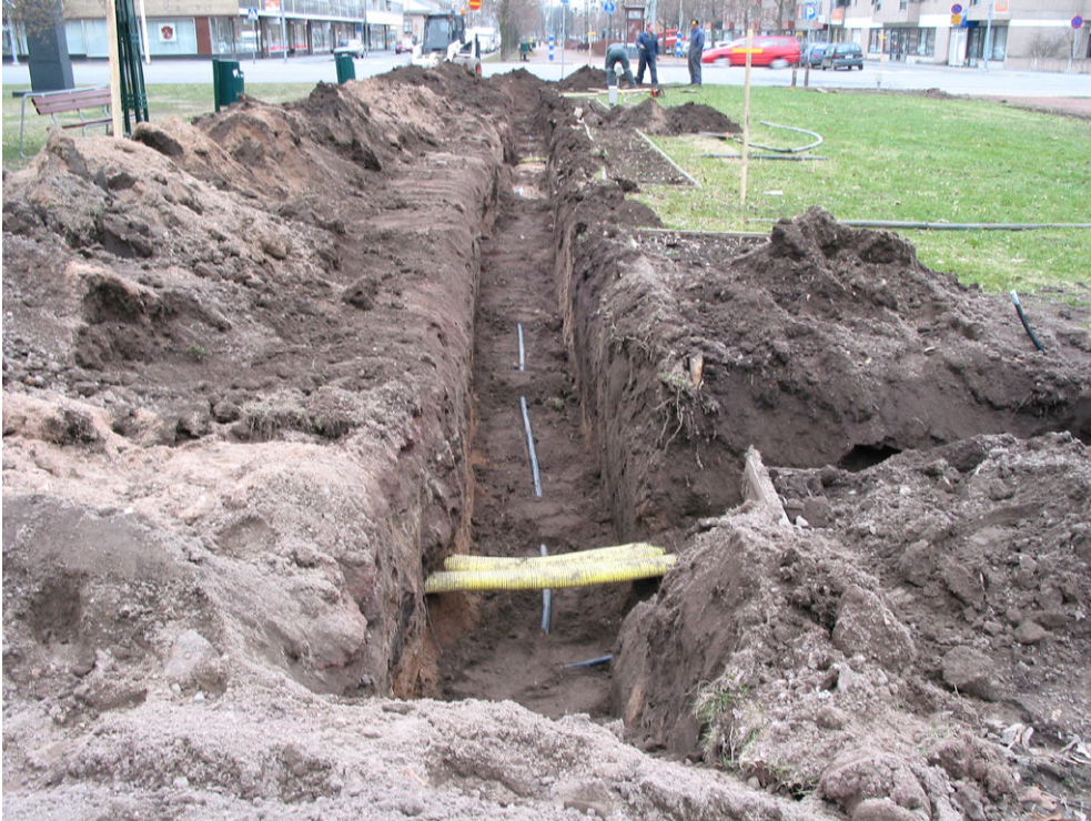
Kuva 2. Näkymä itäpuolen kaivannosta seurannan alkaessa 25.4.2007 kuvattuna etelään (Valtakadulle). Kuva: Mikko Helminen.
