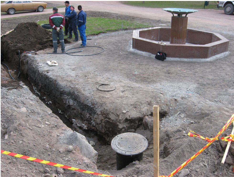
Kuva 7. Suihkukaivoon liittyvä resentti sora ja styrox-levypohjustus länsipuolen ojan itäleikkauksessa kuvattuna lounaasta 2.5.2007. Kuva: Mikko Helminen.
