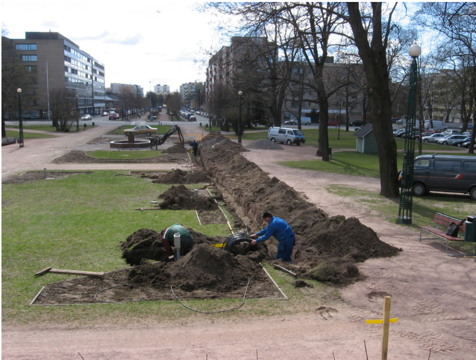
Kuva 11. Länsipuolen oja päätettiin pohjoisen nurmialueen pohjoispäähän. Kuva: Mikko Helminen.
