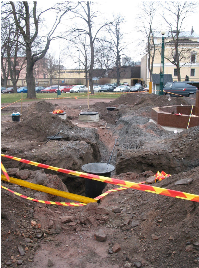
Kuva 1. Suihkukaivon eteläpuolella sijainnut länsi-itäsuuntainen kaivanto kuvattuna idästä. Kuva: Mikko Helminen.
