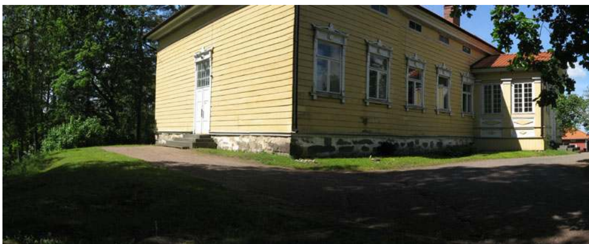
Kuva 14. Pappilan päärakennuksen edustaa kuvattuna idästä. Kuva: Mikko Helminen 18.6.2008.
