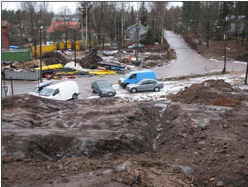
Kuva 11 Kallioon louhittu salaoja R7. Kuva: John Lagerstedt 2008.
