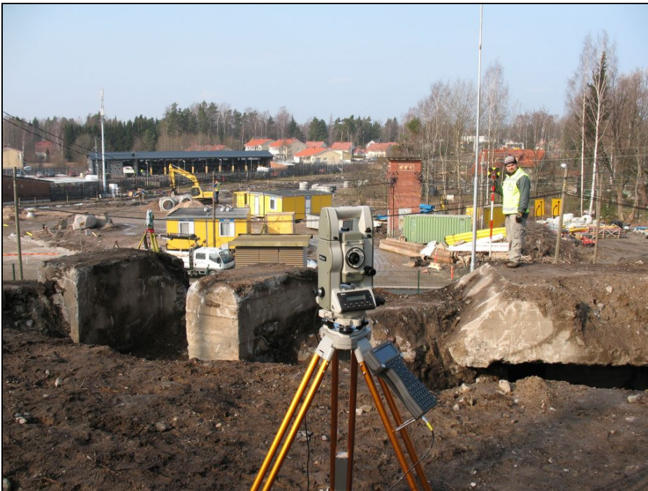
Kuva 3 Rakenteet kartoitettiin takymetrillä. Ilari Kurri Suojahuoneen R1 katolla, vasemmalla konekivääriasema R2. Kuva: John Lagerstedt 2008.
