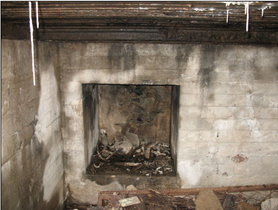
Kuva 5 Suojahuoneen R1 länsinurkassa oleva komero. Betoniseinien ja katon välissä on tila teräspalkkivahvistukselle, joka on poistettu. Takaosan betoniin on painautunut kiskon ja siinä olleen leiman kuva. Kuva: John Lagerstedt 2008.
