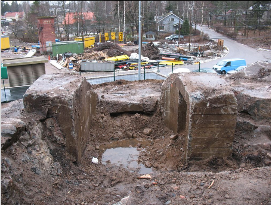
Kuva 7 Konekivääriasema R2 nähtynä takaa. Oikeassa seinässä asean jäähdytysvesisäiliön komero, keskellä ampuma-aukon alla konekiväärin jalustasyvennys. Kuva: John Lagerstedt 2008.
