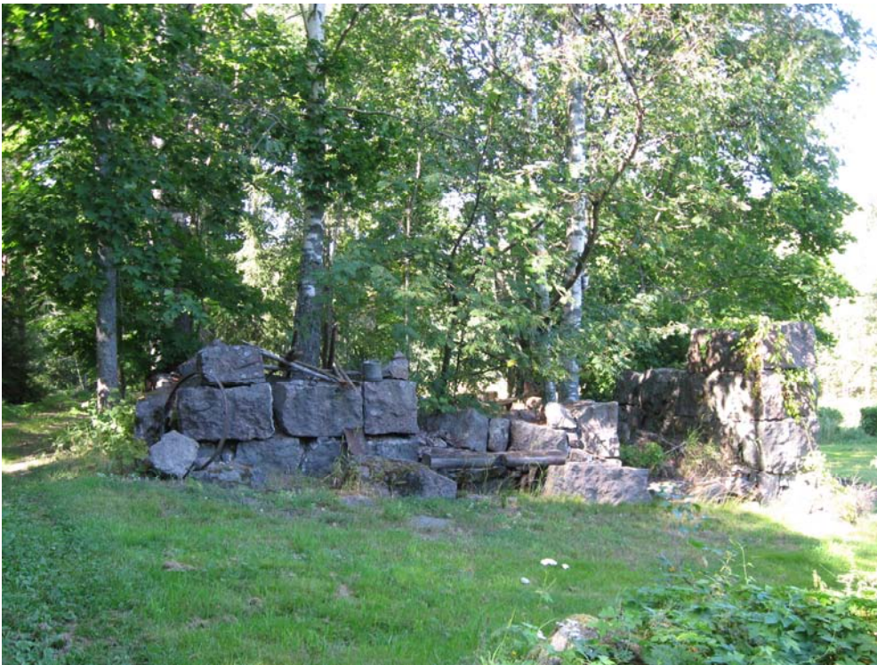
Kuva 40. Navetanraunio. Eteläkoillisesta. Kuv. k. Vuoristo.
