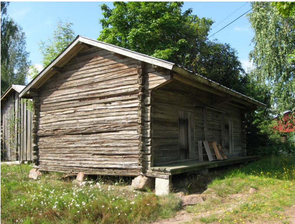
Kuva 49. Jaakkolan aitta 1850-luvulta. Etummaisesta nurkasta näkyy maahan painunutta kivistä kiviriviä. Aitan alla on todennäköinen uunipaikka. Koillisesta. Kuv. K. Vuoristo.
