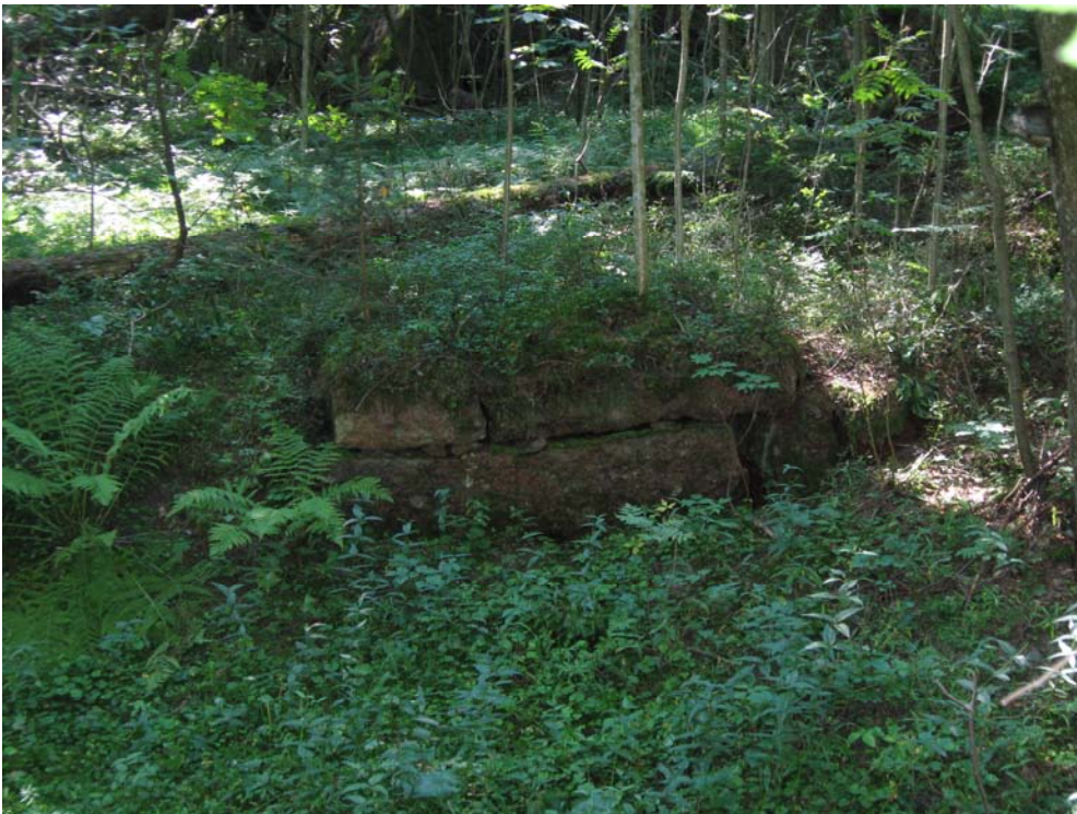
Kuva 22. Mantereella puronpenkassa sijaitsevan sillanperustukset. Koillisesta. Kuv. K. Vuoristo.
