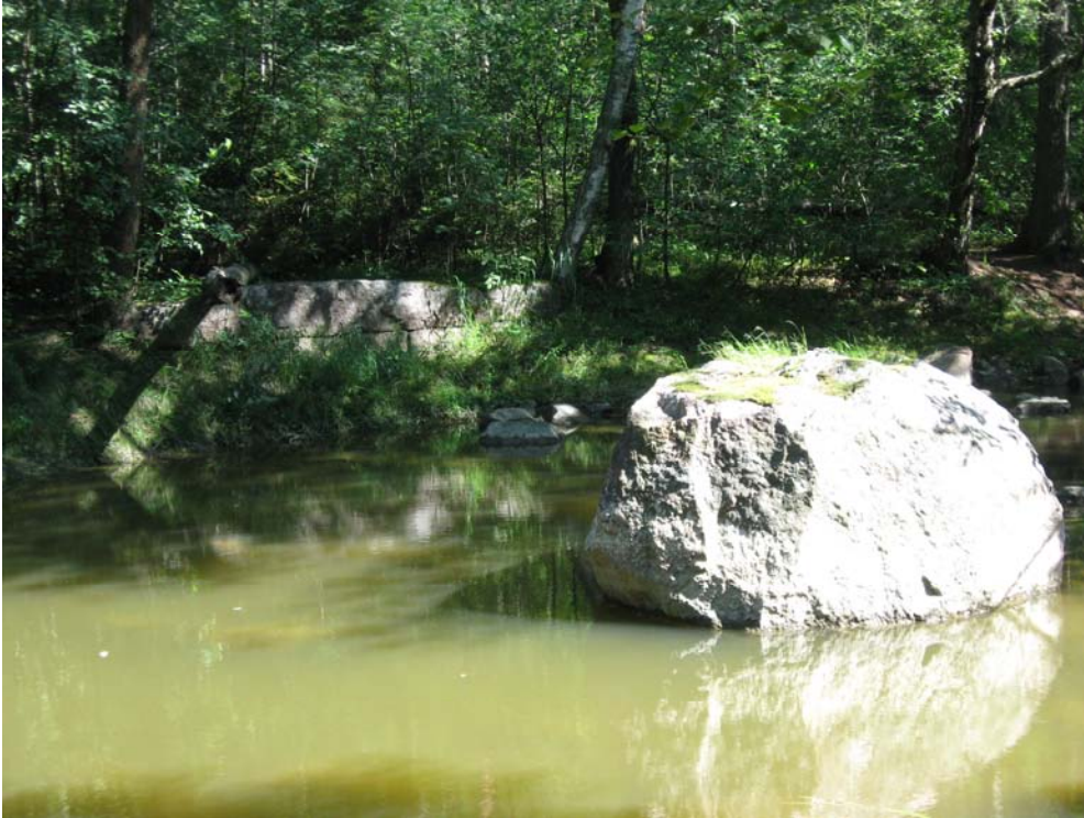
Kuva 21. Mantereen puolella joenrannassa sijaitseva sillanperustus. Edessä kivi, joka on todennäköisesti toiminut sillan tukikivenä. Länneestä. Kuv. K. Vuoristo.
