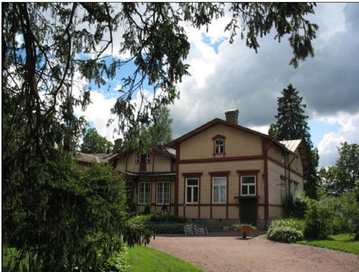
Kuva 10 Pappilan yksittäistilan kohdalla nykyään sijaitseva Vanhan Pappilan päärakennus. Kuva: JL 2008.
