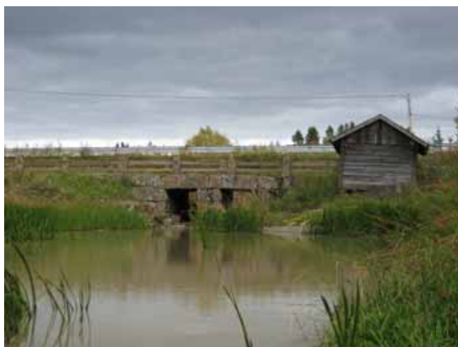
Digikuva 125936:30. Käytöstä jäänyt silta ja hirsivaja, jonka vieressä myllynkivet sijaitsivat. SW-NE. Kuva K. Vuoristo.
