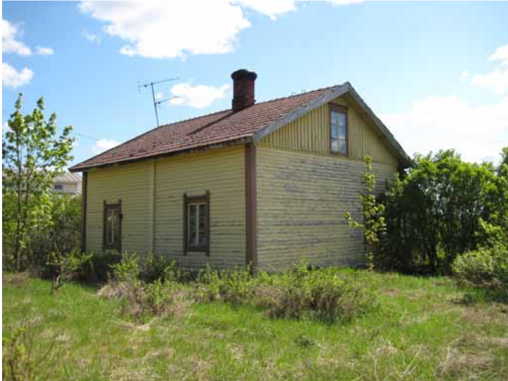
Digikuva 125938:16. Yleiskuva. Lanttan autioksi jäänyt päärakennus. Talon etummaisena nurkan kohdalla on säilynyt vanhemman rakennuksen jäännöksiä. NE-SE. Kuva K. Vuoristo.
