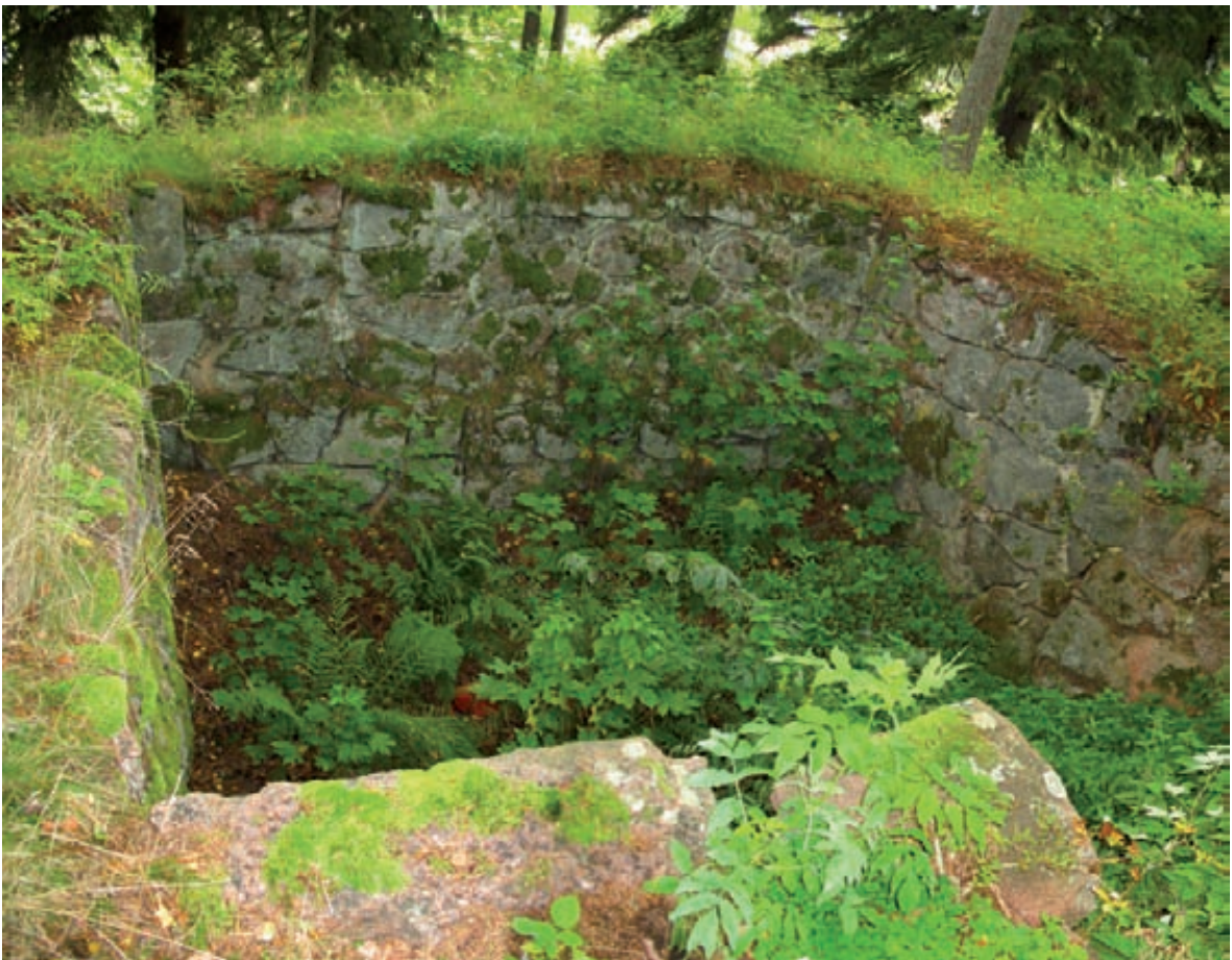
DG605:15 Anjalankoski Mubniemi (Mubuniemi), Wredebyn kartanon vanha jääkellari. Panoraama. N-S, 11.9.2008 J. Enqvist, MV/RHO.
