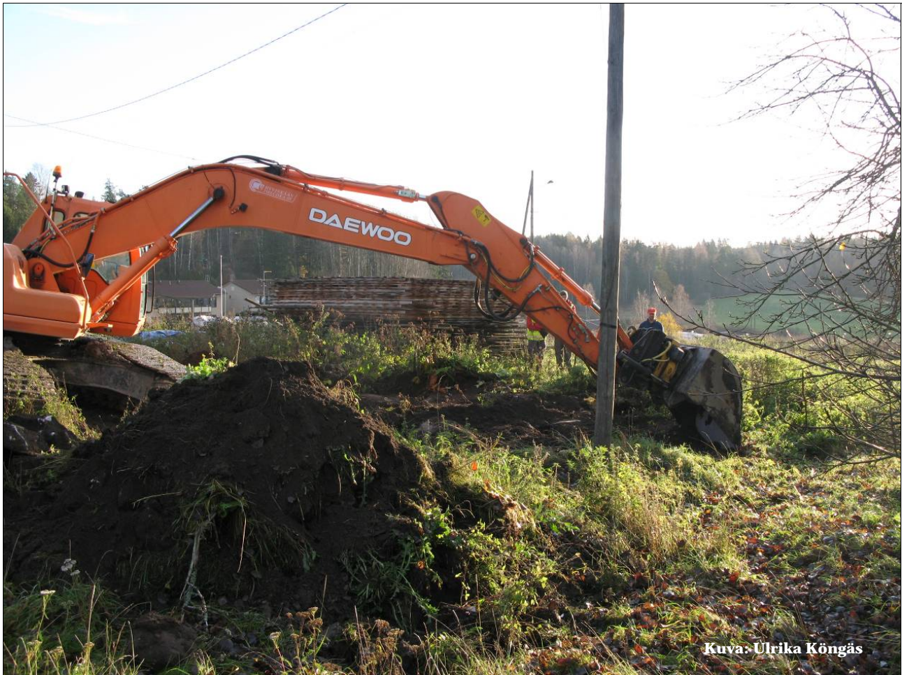
Kuva 2: Turpeita ja pintamaata poistettiin koneellisesti.
