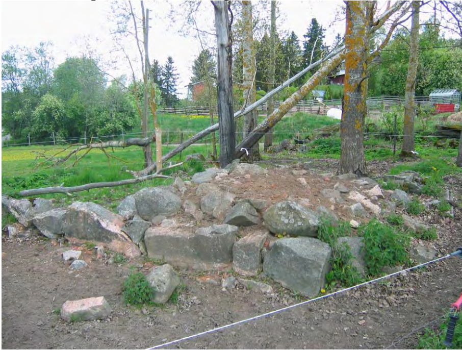
Kuva 62 (df. 125939:100). Nurmijärvi Valkjärvi 2. Vanhan tallirakennuksen perustukset. Kuva etelästä.
