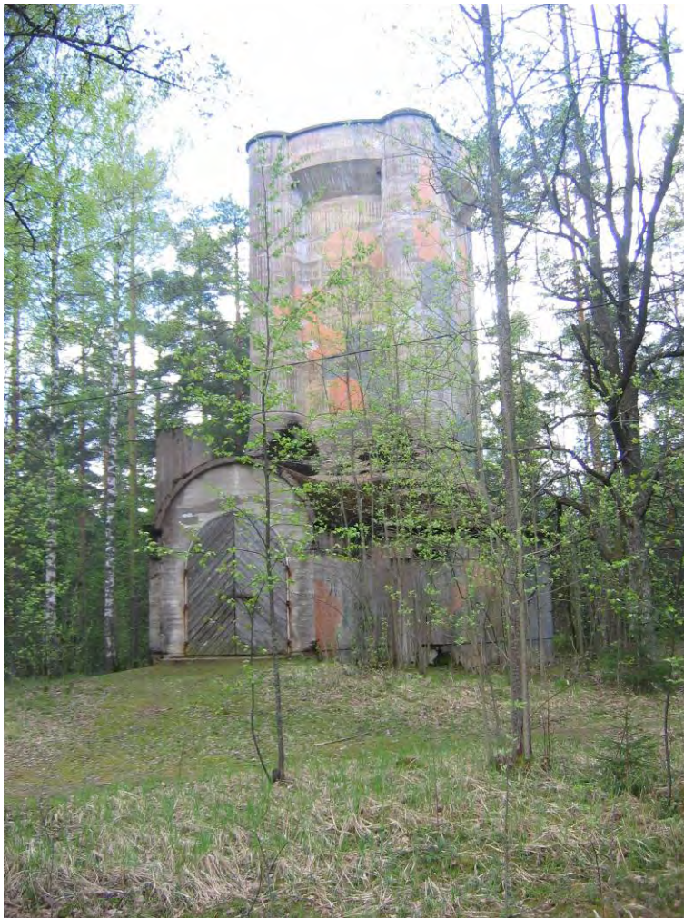
Kuva 103 (df. 125939:36). Nurmijärvi Rajamäki. Kaakkoinen ilmatorjuntabunkkeri. Kuva lännestä.
