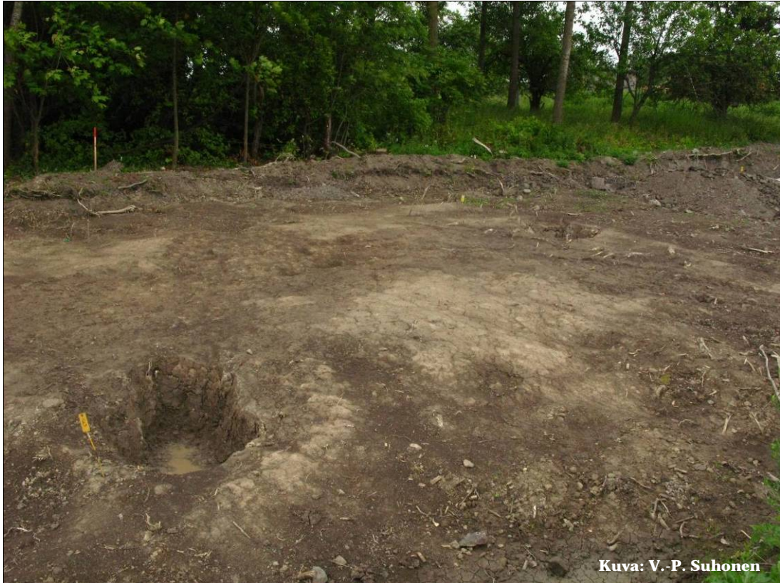
Kuva 10 Rakennus 2 pohjaan kaivettuna.
