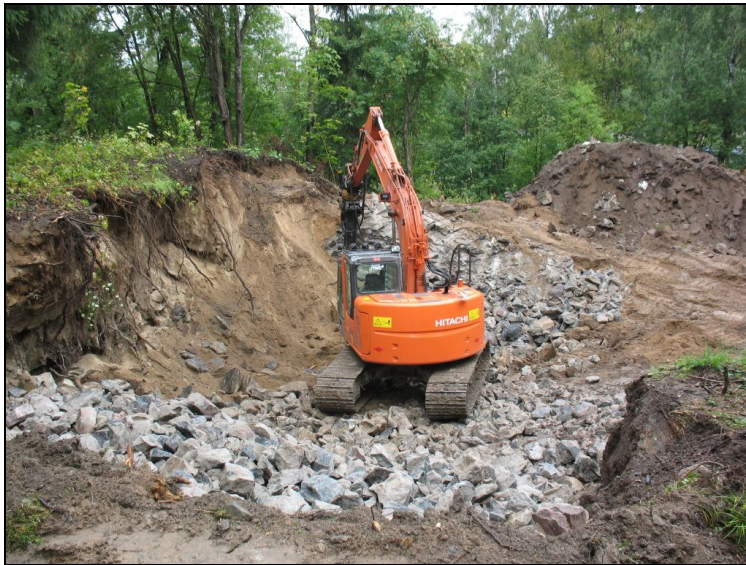
Kuva 10 Tutkimusten päätyttyä purettiin turvallisuussyiden takia jäljelle jääneet katon ja seinien osat kaivinkoneella. Kuva: John Lagerstedt, 2008.
