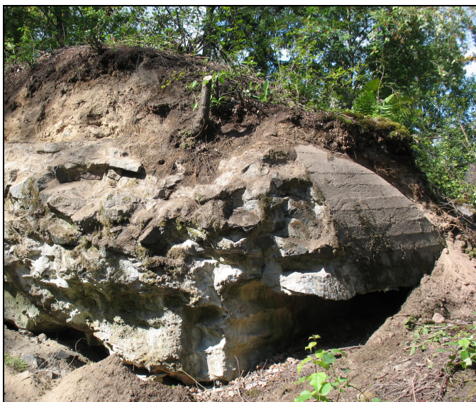
Kuva 5 Suojahuoneen koillisnurkan ehjästä betonikaton kappaleesta pystyttiin alkuvaiheessa tunnistamaan suojahuoneen rakennetyyppi ja betoniin jääneistä hirsien painaumista määrittämään kaksinkertaisen hirsiseinän paksuus. Kuva: John Lagerstedt, 2008.
