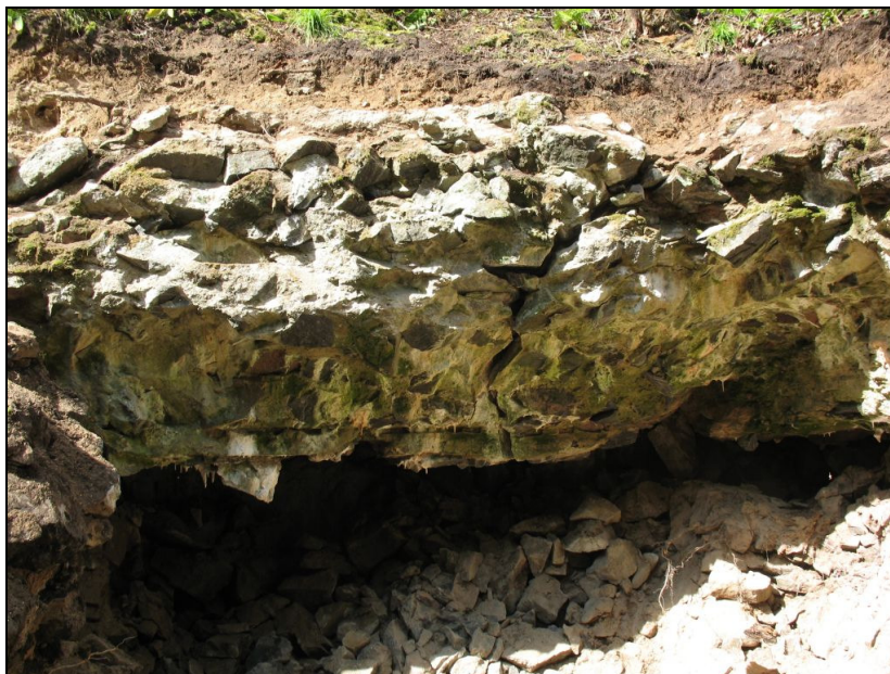
Kuva 12 Katon rakenne suojahuoneen lounaisnurrassa. Katon alaosassa erottuvat kiskojen ja lautojen jäljet ja niiden päällä kaarevana, holvimaisena muotona 0,5 m paksu hiekkakerroksen paikka. Sen yläpuolella on säästöbetonikerros, joka on peitetty hiekalla, jonka päällä on turvekerros. Kuva: John Lagerstedt 2008.
