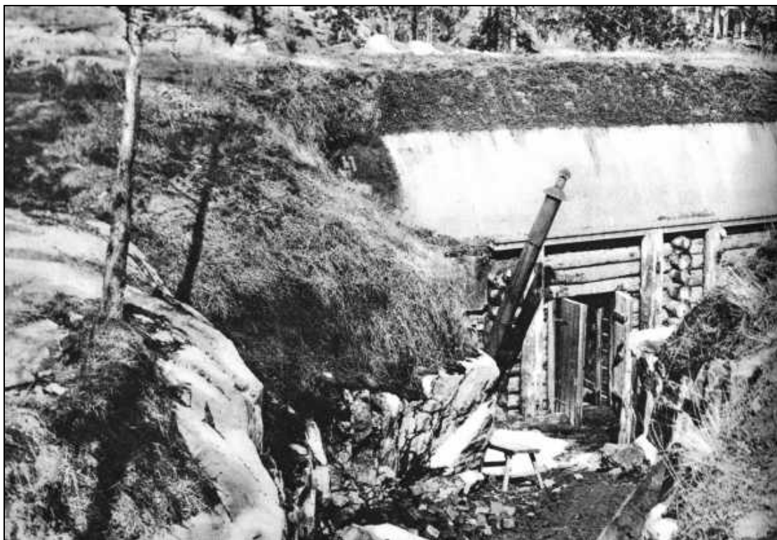
Kuva 4 Espoon Leppävaaran alueella Helsingin valtauksen jälkeen, keväällä 1918 valokuvattu suojahuone ja sen eteen johtava yhdyshauta. Kuvan suojahuoneen rakenne on saman tyyppinen kuin Ruukinrannan suojahuoneessa, joka on kuitenkin ollut huomattavasti kookkaampi. Ulkoseinä on rakennettu hirsistä ja seinän päällä näkyy betonikaton paljas reuna. Betonikaton yläpinta on peitetty maalla ja naamioitu turpeilla. Pariovilla varustetun sisäänkäynnin vasemmalla puolella on uunin savuhormi. Kuva kirjasta: Suomen vapaussota kuvissa – osa II. Otava.
