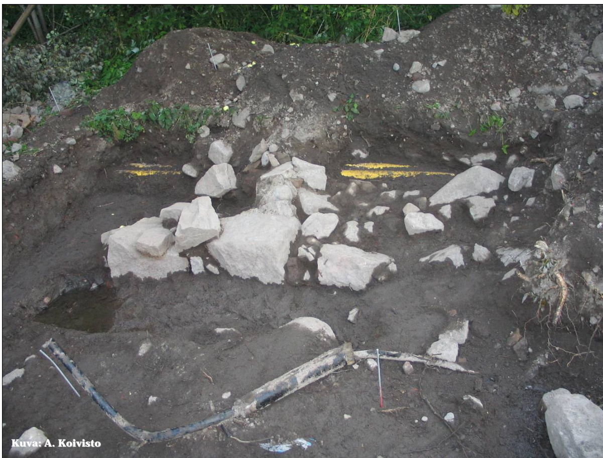
Kuva 22: Kivijalka R102. Kivijalan takana näkyy vuonna 2005 vedettyjen sähköjohtojen putket.
