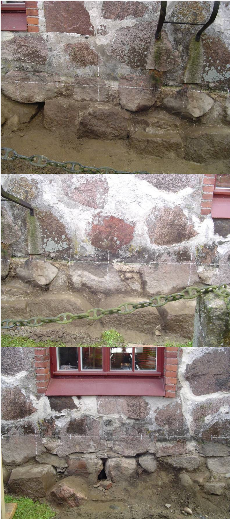
Kuvat 3-5. Kirkon pohjoisseinästä ulostyöntävä vanhempi kirkon perustus
