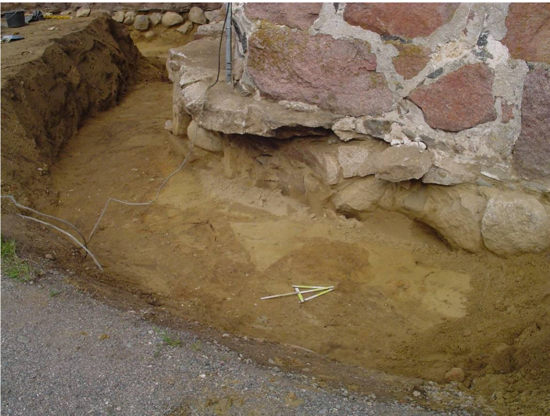
Kuva 2. Kirkon lounaisviisteen perustus. Huomaa tyhjä tila nykyisen perustuksen alla.
